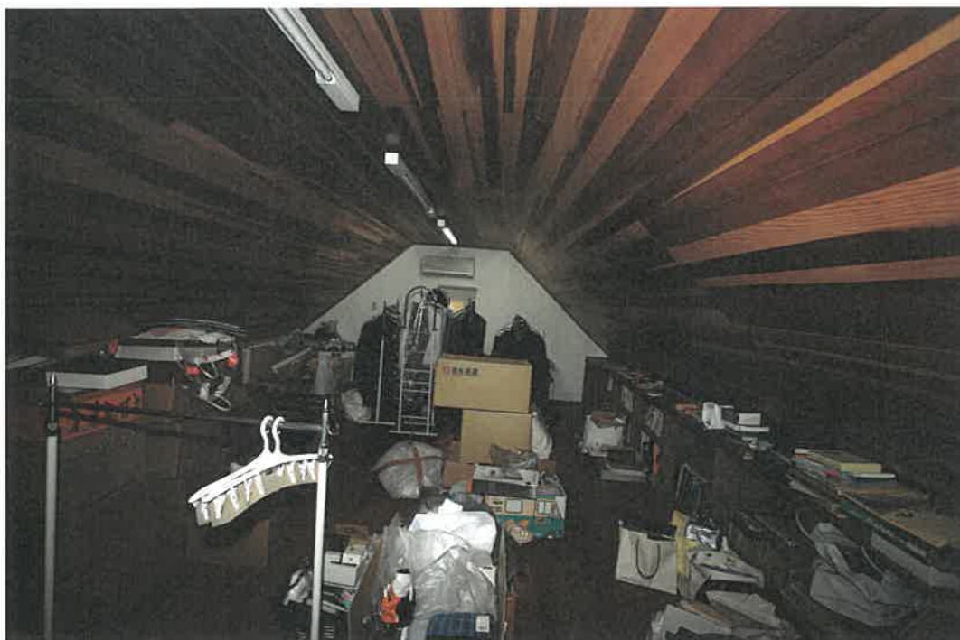
物件 2 建物 3 階室内
