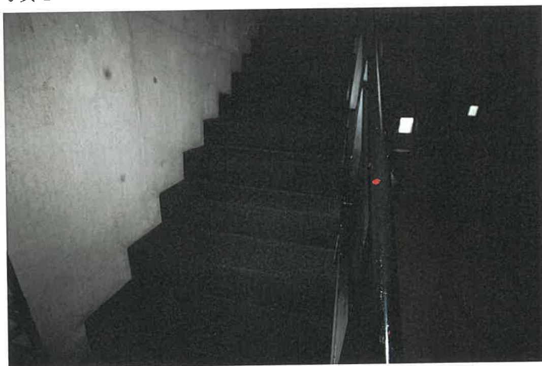
物件 2 建物 1 階から 2 階への階段
