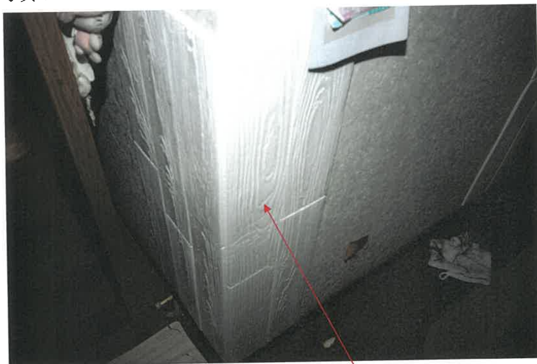
物件 2 建物 1 階室内
