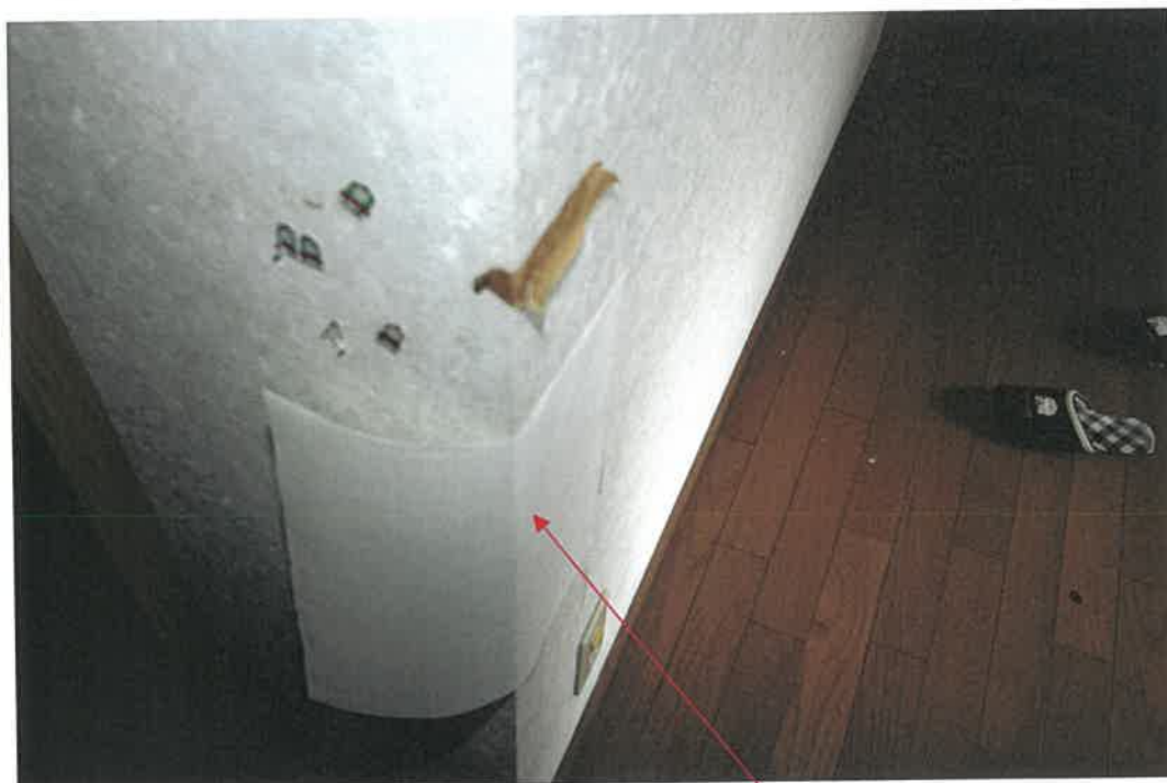
物件 2 建物 1 階室内
