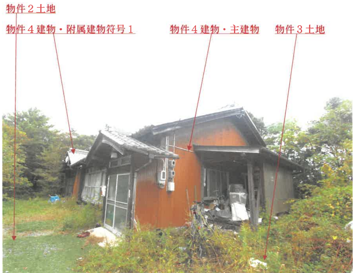
目的物件の現況写真
