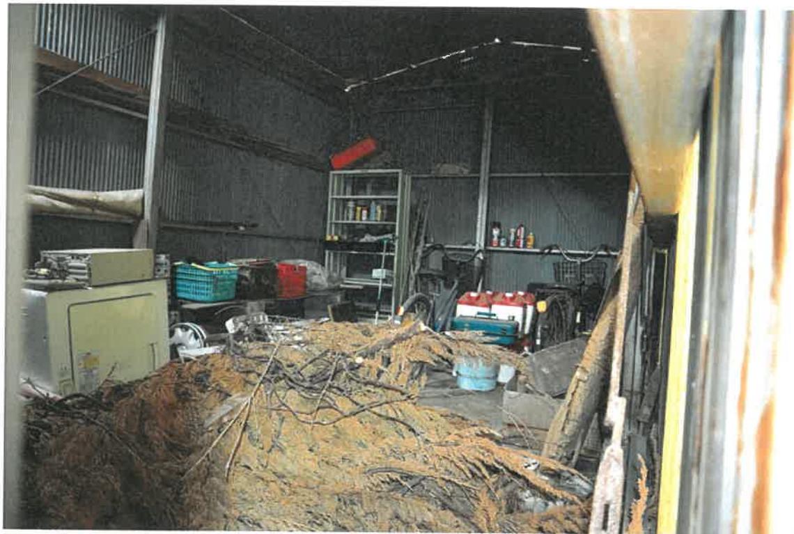
物件 2 附属建物 1 内
