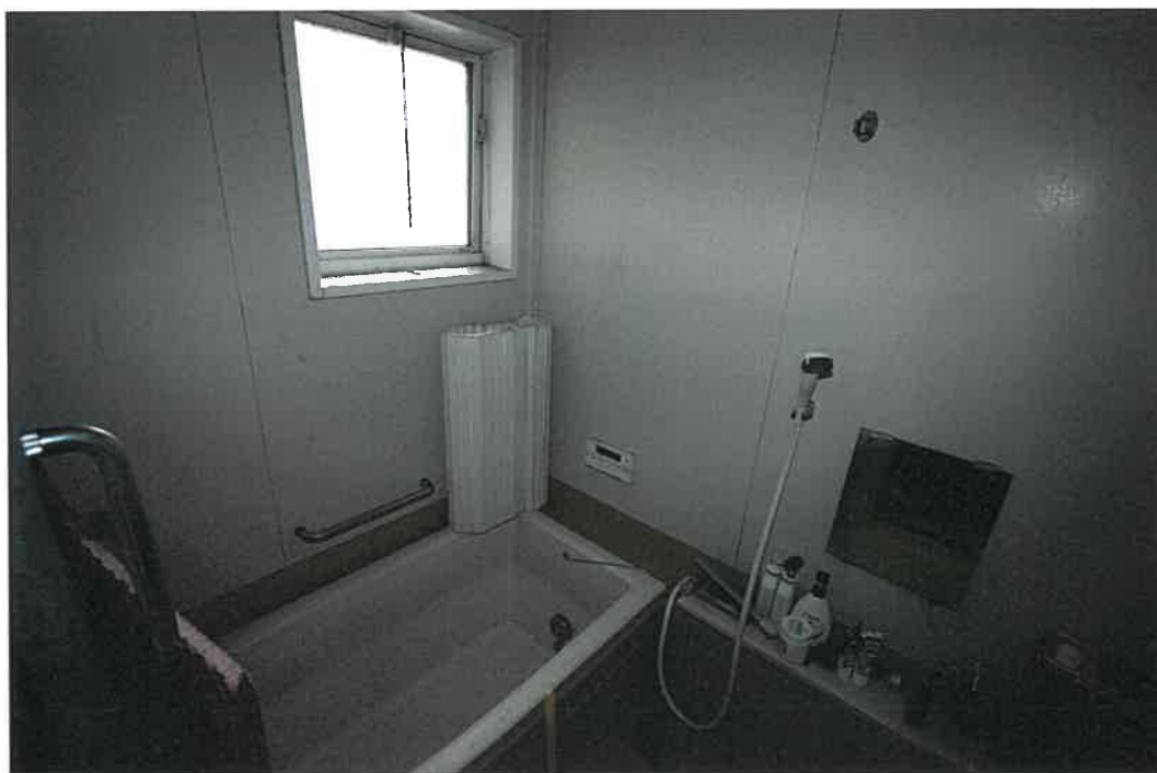
物件 2 建物 1 階室内
