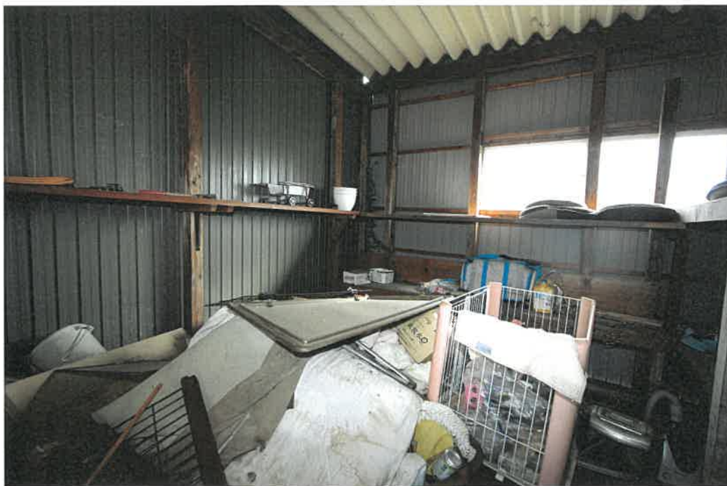
物件 5 附属建物 2 室内
