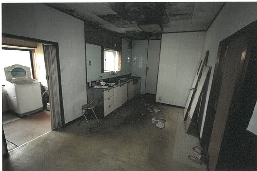
物件 5 主建物 室内
