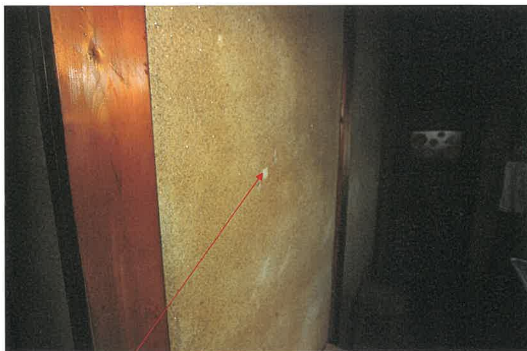
穴 物件 5 附属建物 1 室内
