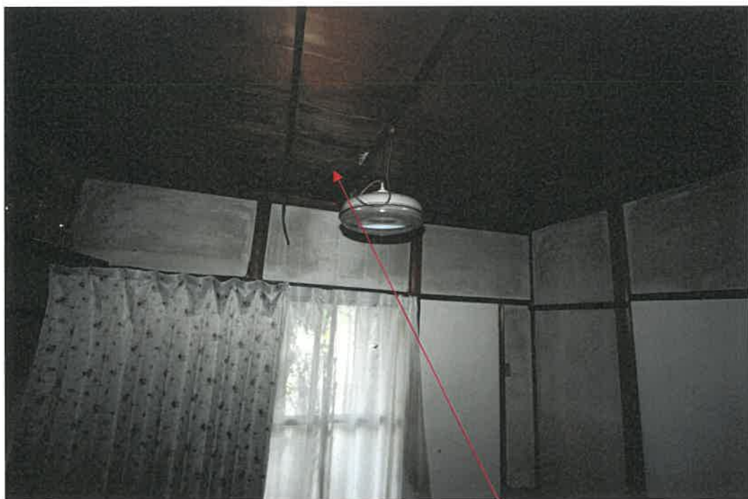
物件 5 主建物 室内
