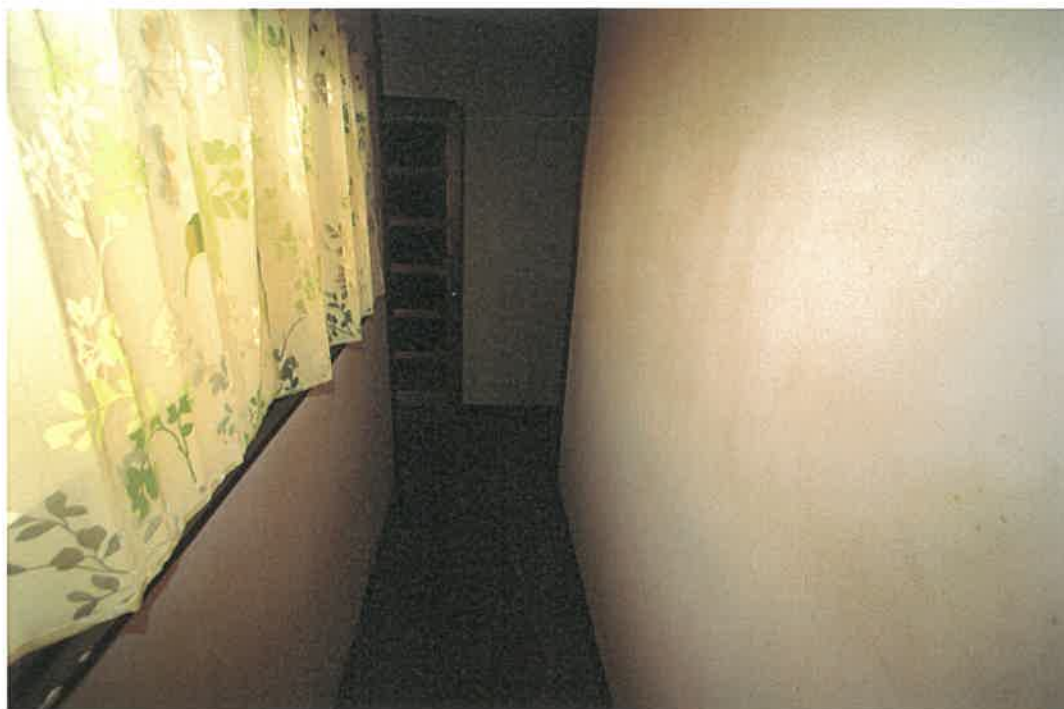
物件 5 附属建物 1 室内
