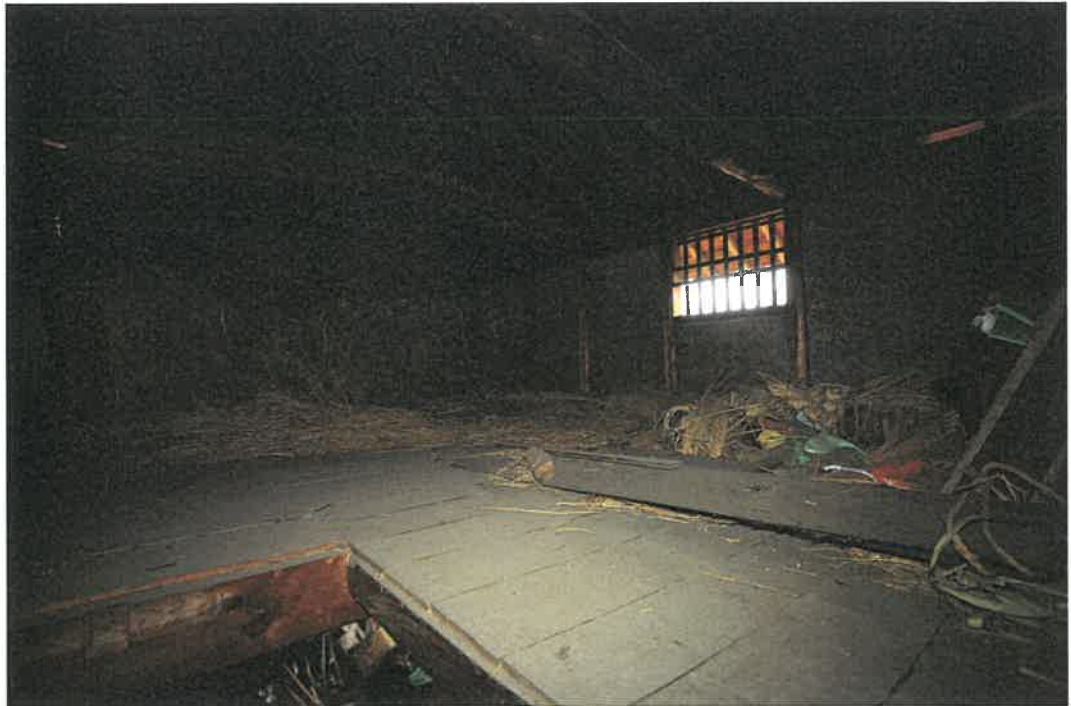
物件 5 附属建物 3 2 階室内
