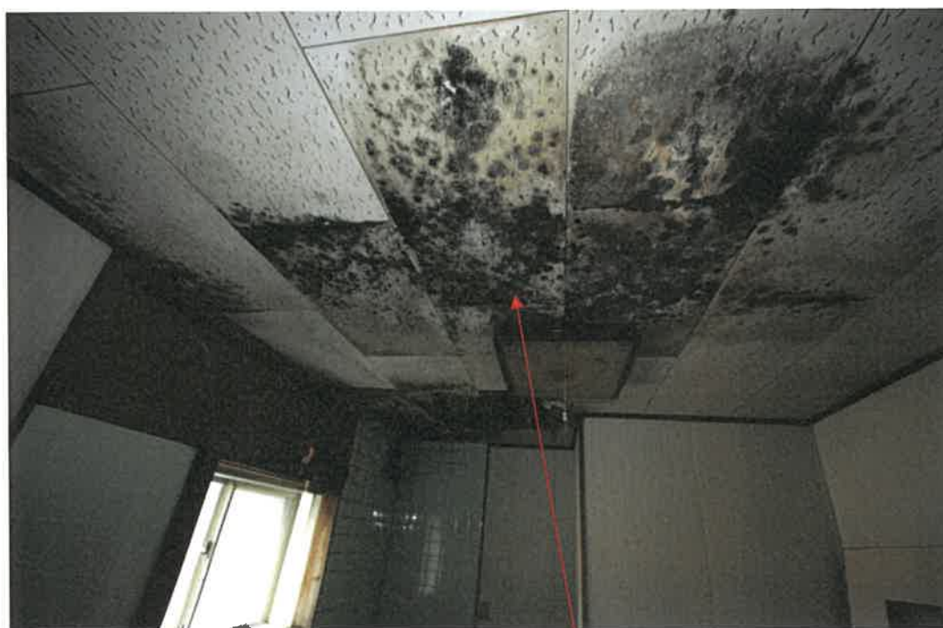
物件 5 主建物 室内
