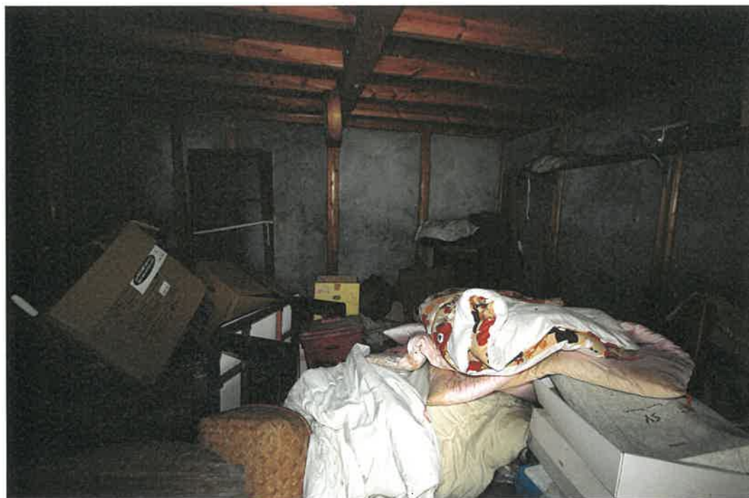
物件 5 附属建物 3 1 階室内
