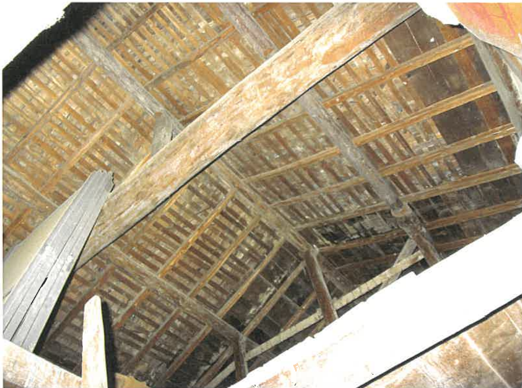
前同建物の2階室内
