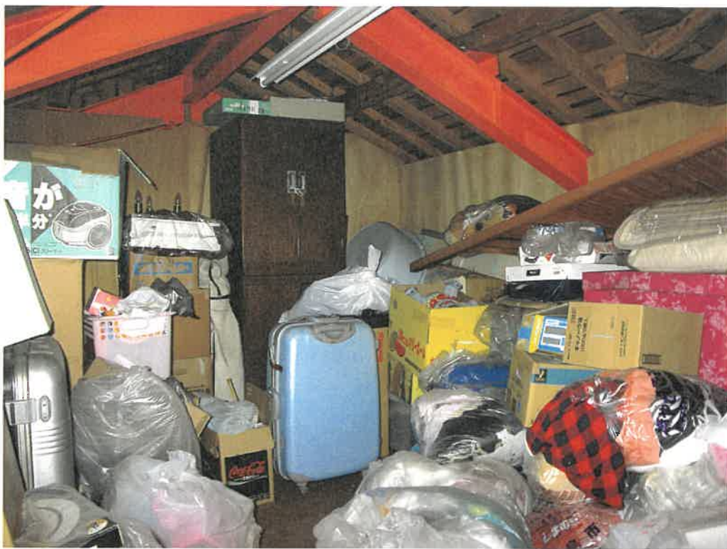
前同建物の2階小屋裏収納内
