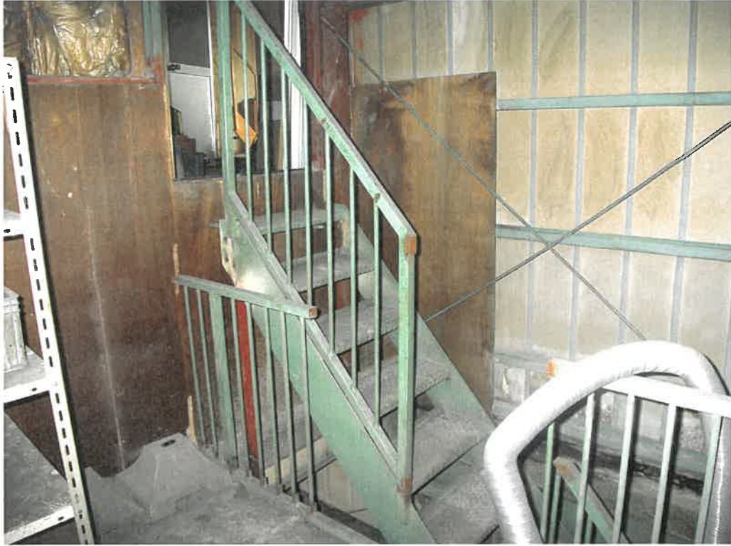
前同建物の2階踊り場内
