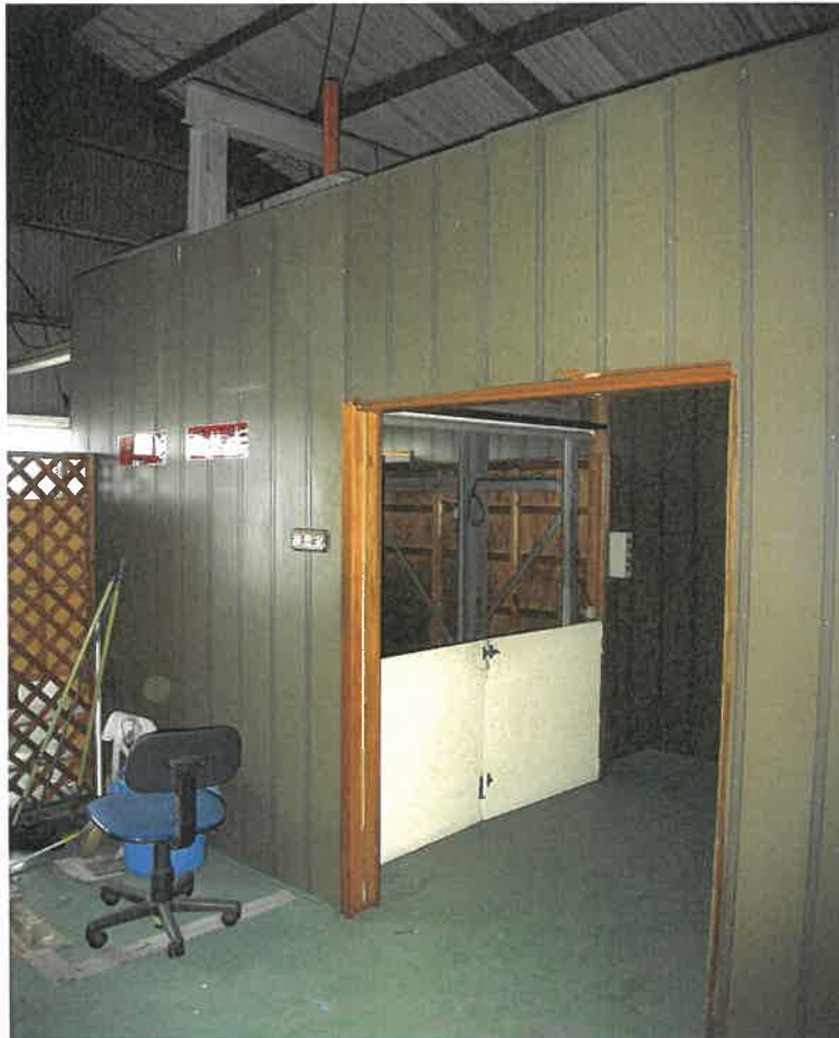
前同建物の2階リフト前
