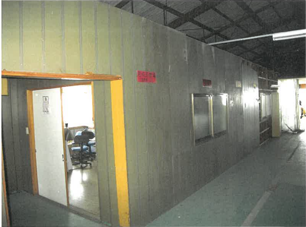
前同建物の2階倉庫前
