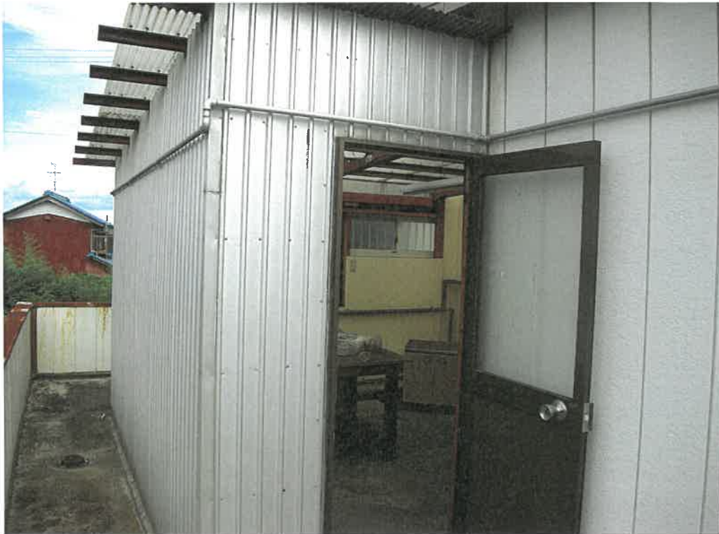
前同建物の2階休憩室前（未登記増築部分）
