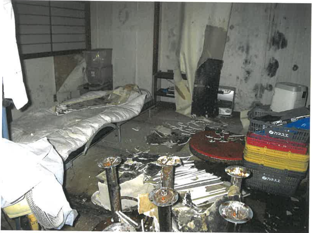
物件3 建物の地下1階店舗内
