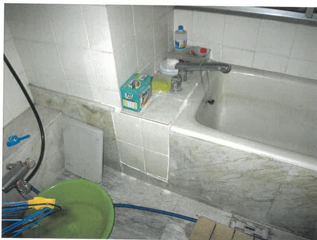
前同建物の3階室内
