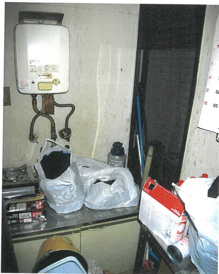
前同建物の2階店舗内
