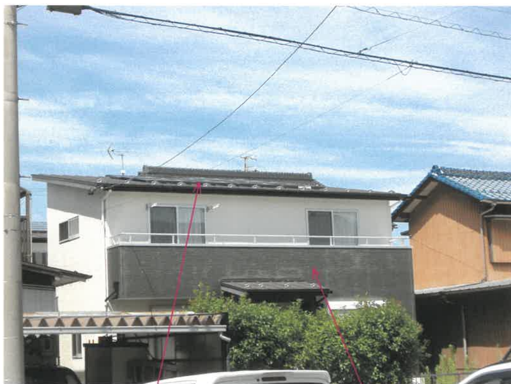
太陽光パネル
