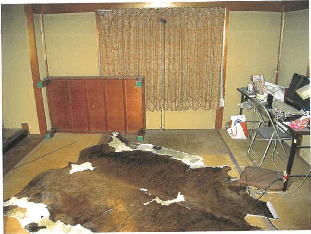
前同建物の2階室内
