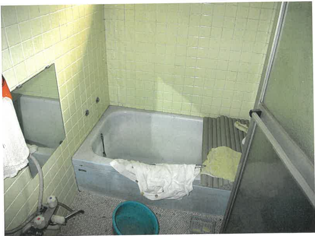
前同建物の1階室内
