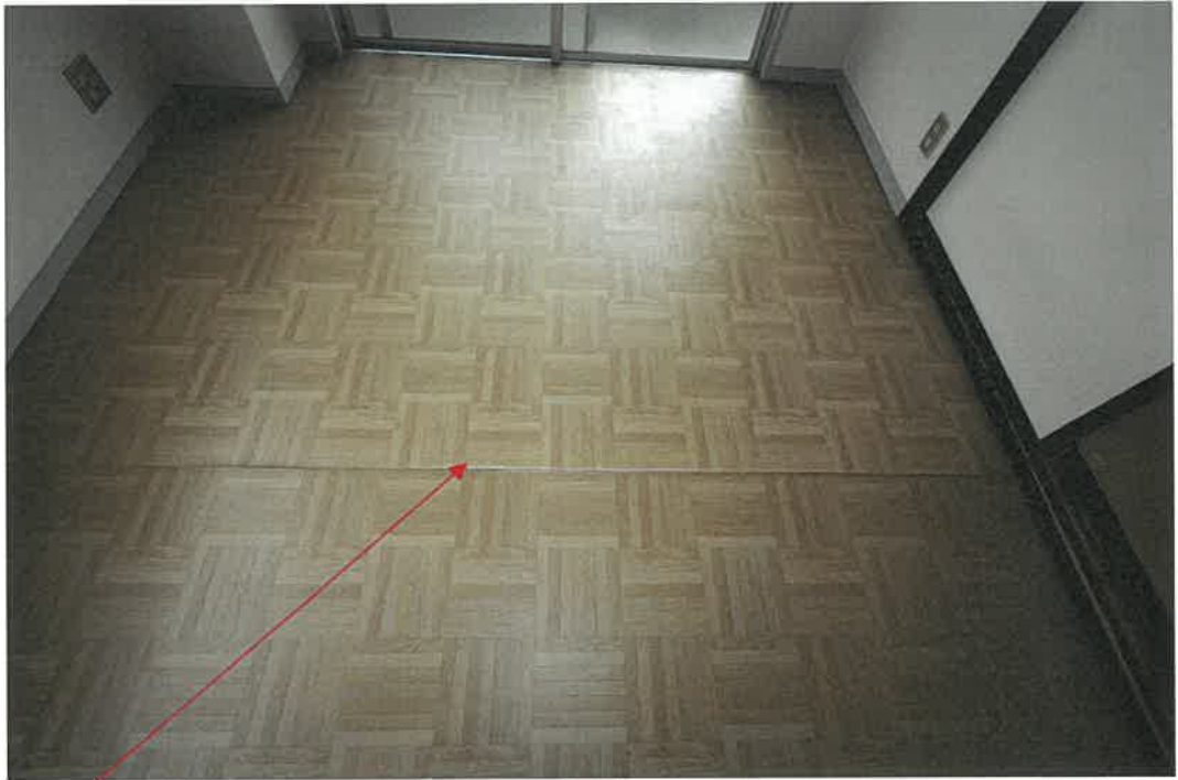
物件 2 建物 3 階 3 0 1 号室 室内 床のタイルの張り合わせがめくれかけている。
