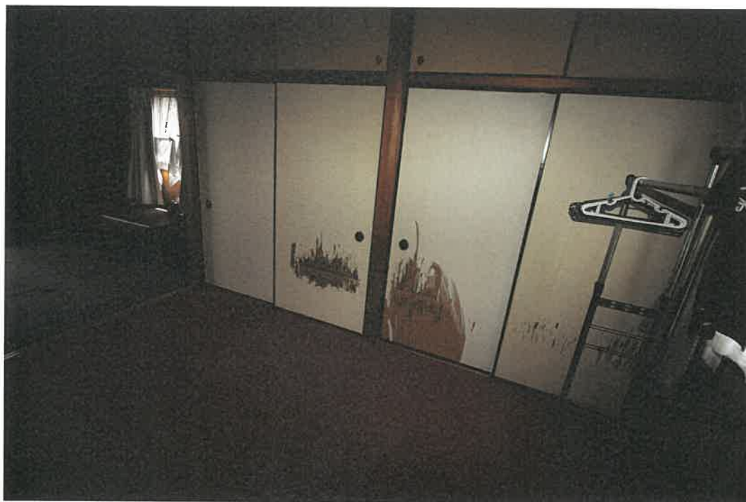
物件 2 建物 2 階室内
