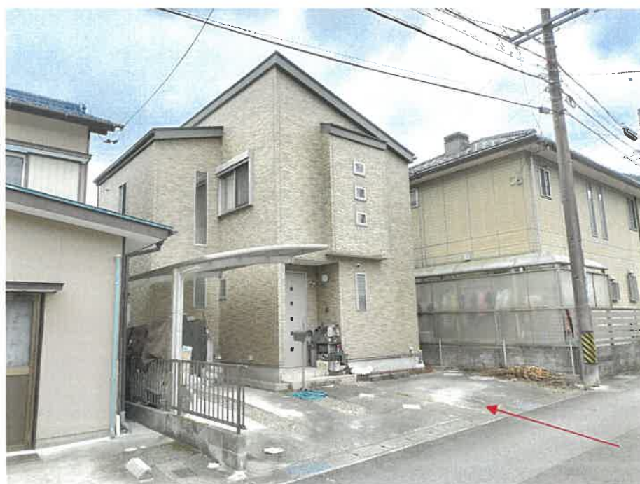
写真番号2 目的物件の北東方より撮影
