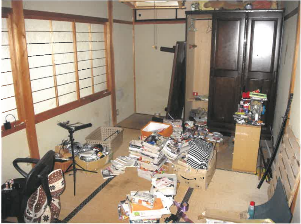
前同建物の1階室内
