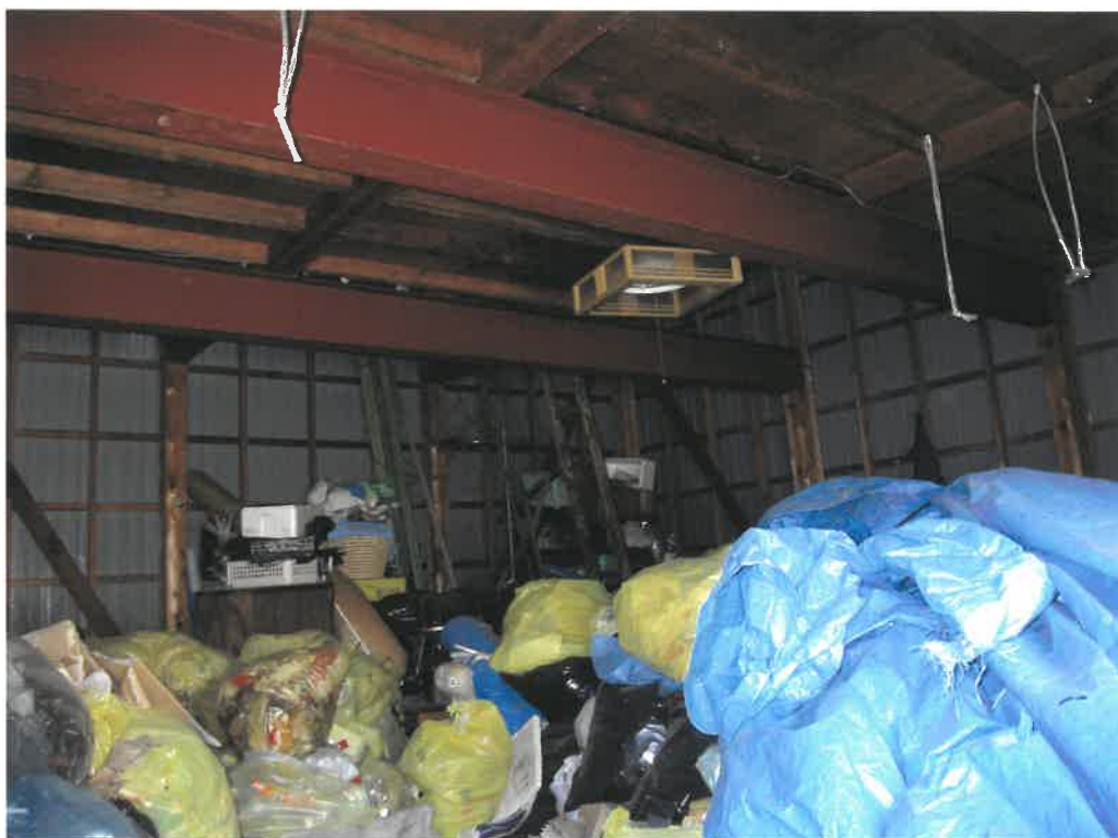
未登記附属建物1の車庫・物置内
