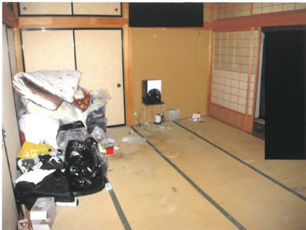
前同建物の1階室内
