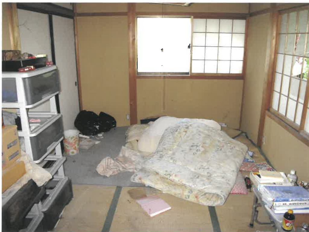
前同建物の2階室内
