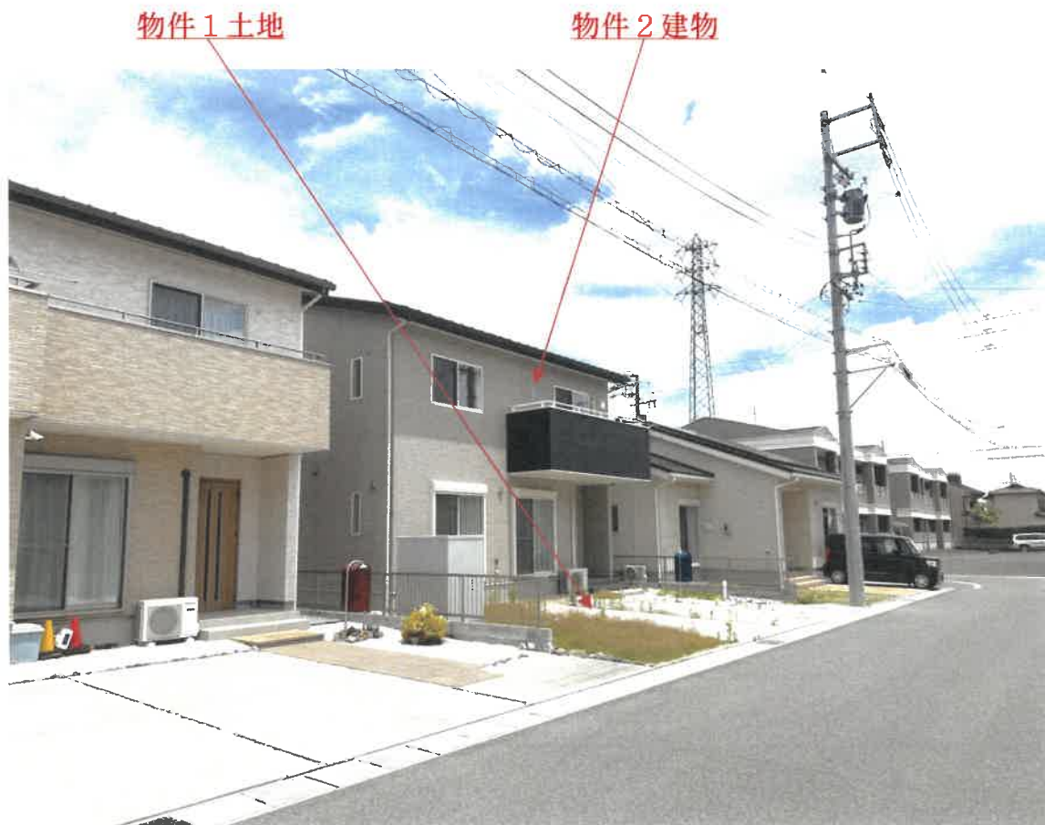
目的物件の現況写真
