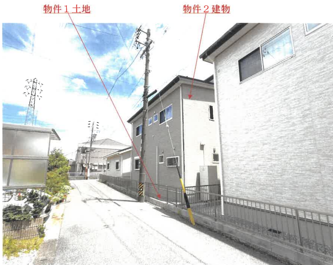
目的物件の現況写真
