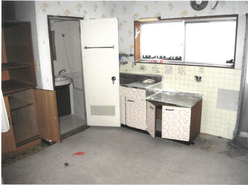
前同建物（東端から2番目）の2階室内
