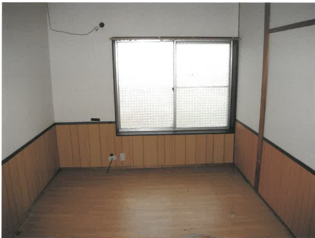
前同建物（東端から2番目）の2階室内
