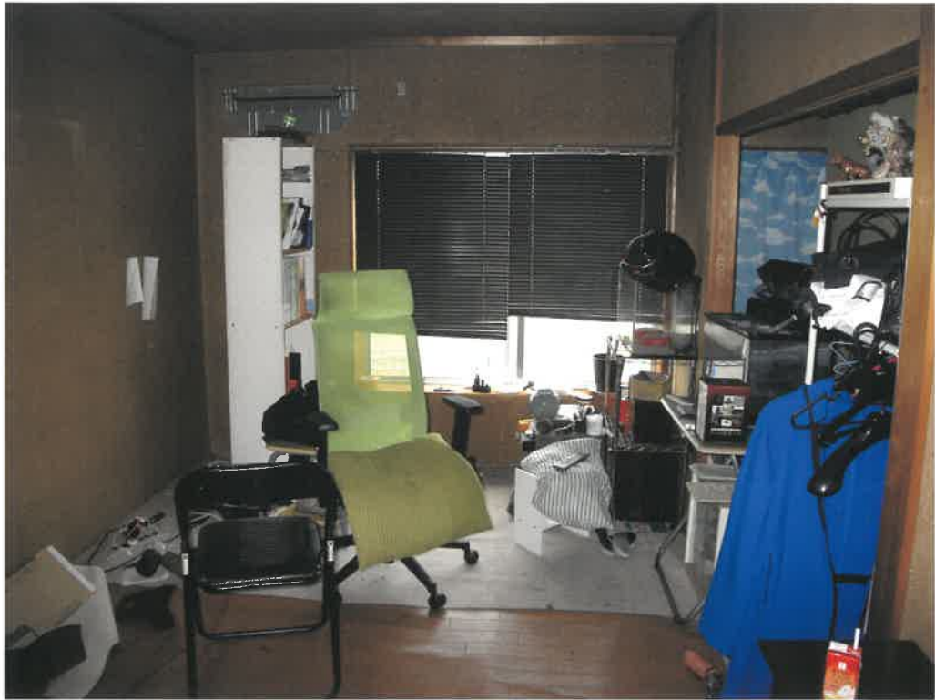
前同建物（西端から2番目）の2階室内
