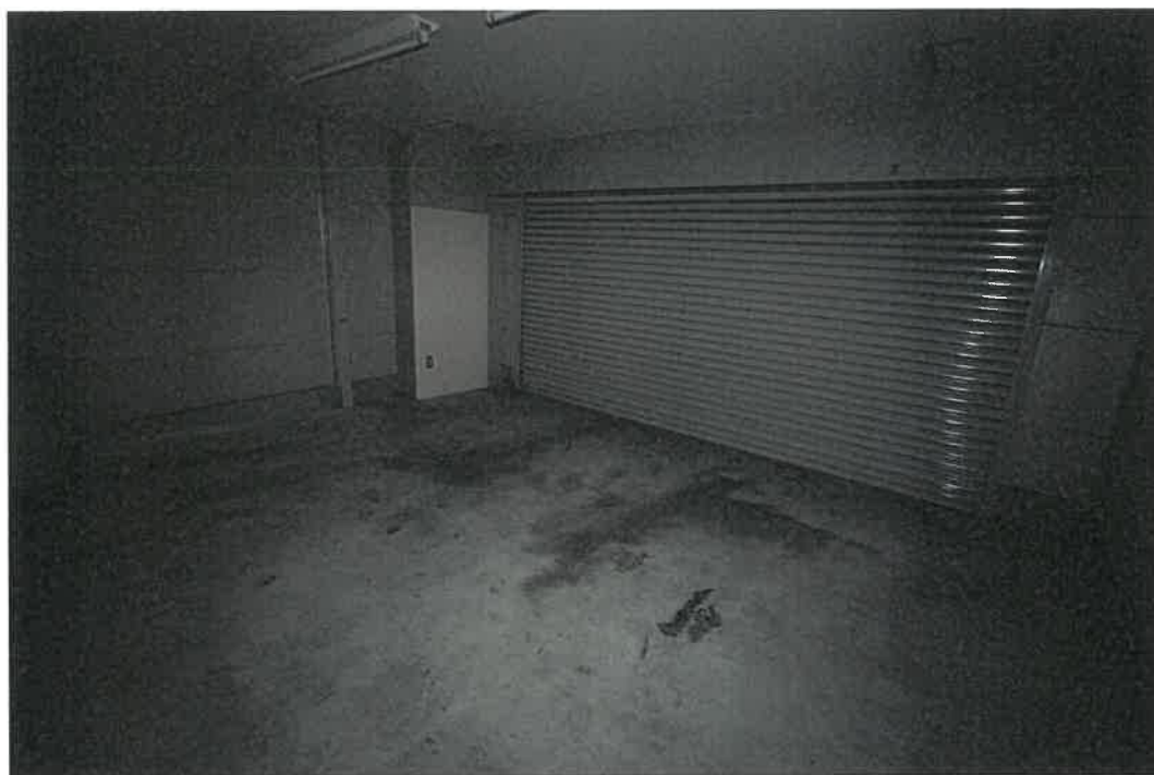
物件 2 建物 1 階室内
