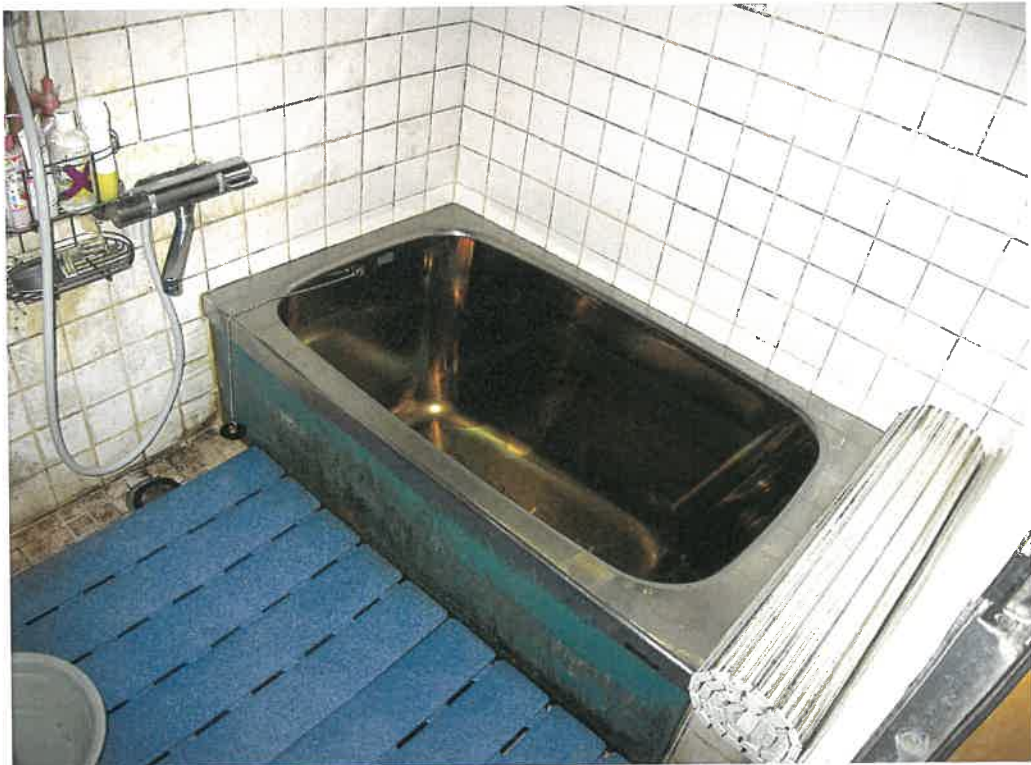
前同建物の1階室内
