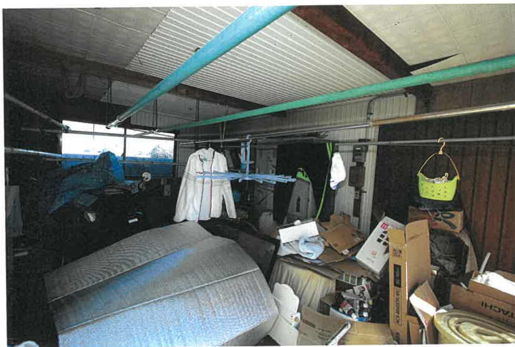
物件 3 建物 1 階室内
