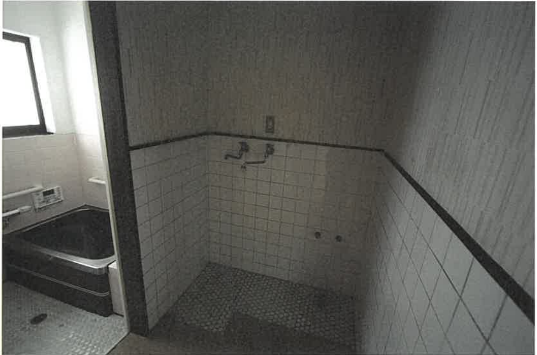
物件 2 建物 1 階室内
