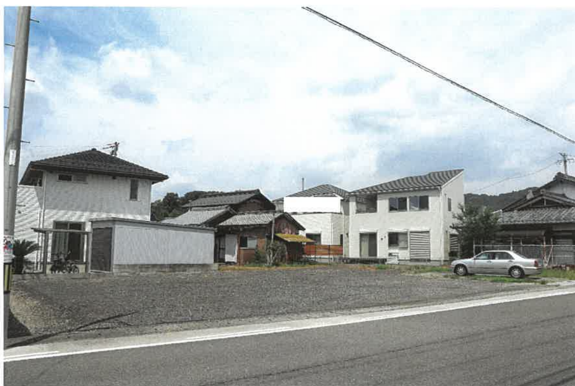
仮設事務所撤去後の物件1 土地の状況
