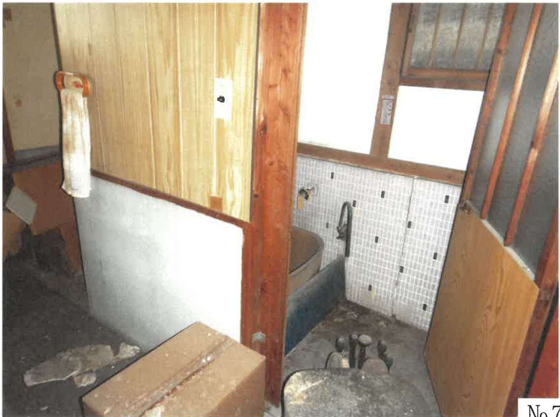
物件4建物 浴室
