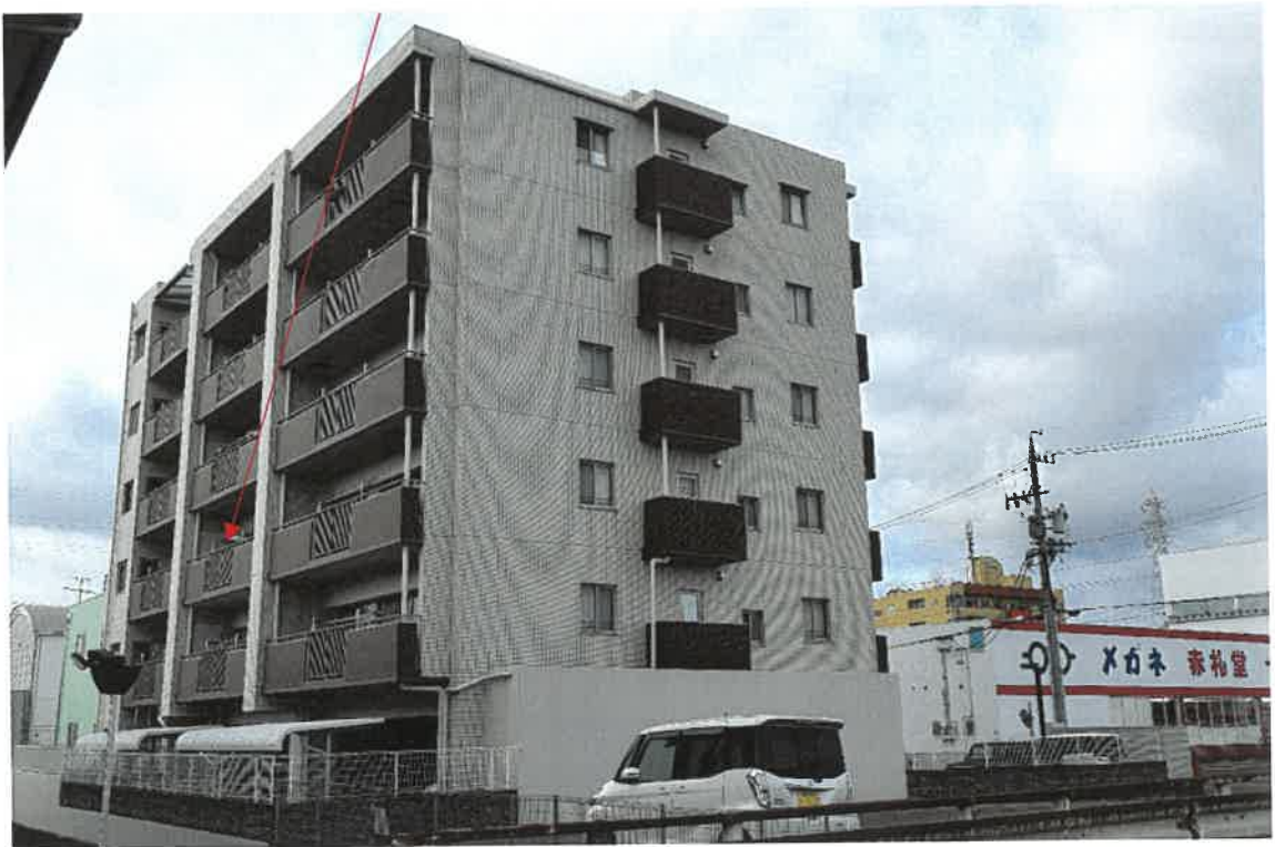
写真4 物件1建物（専有部分）
