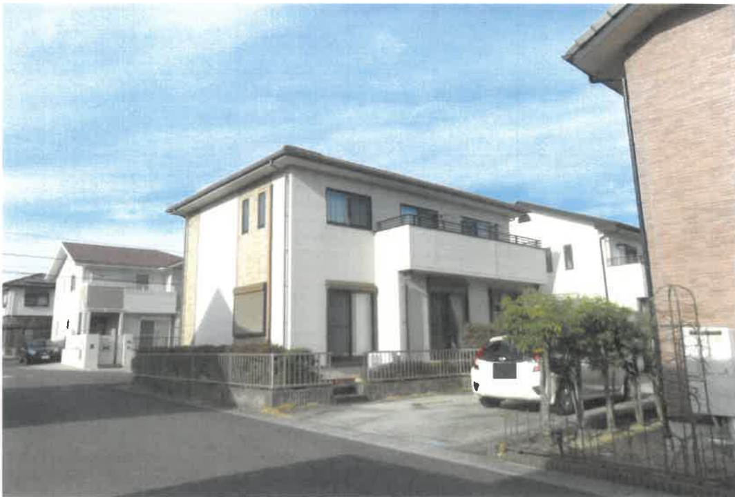
物件土地建物の南方から撮影
