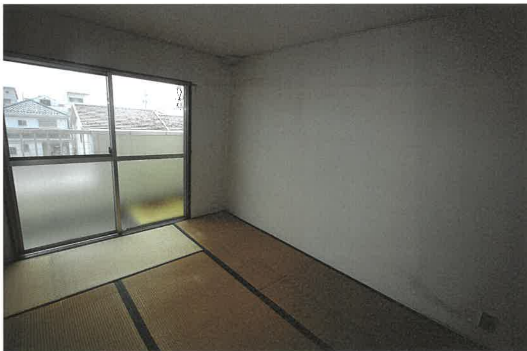
物件 2 建物 3 階 3 0 1 号室 室内
