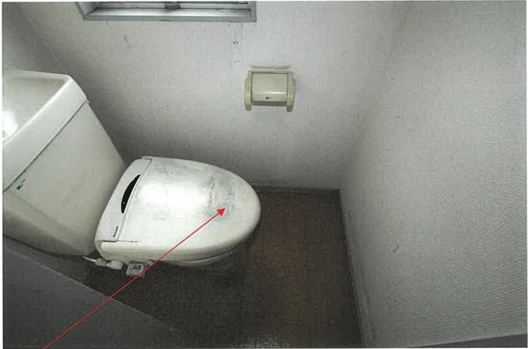
物件 2 建物 3 階 3 0 1 号室 室内 トイレの蓋が汚れている
