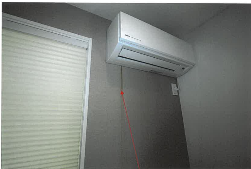
物件 3 建物室内
