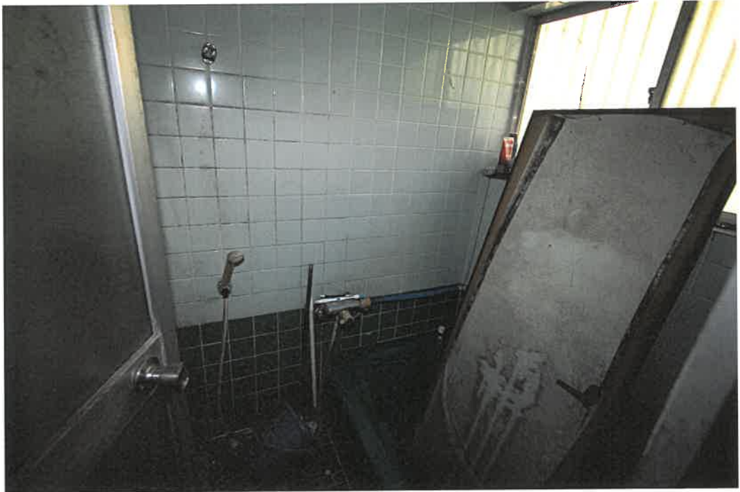
物件 3 建物 1 階室内
