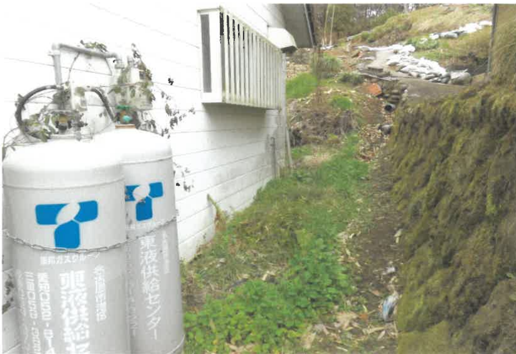
物件3建物の東側部分を撮影
