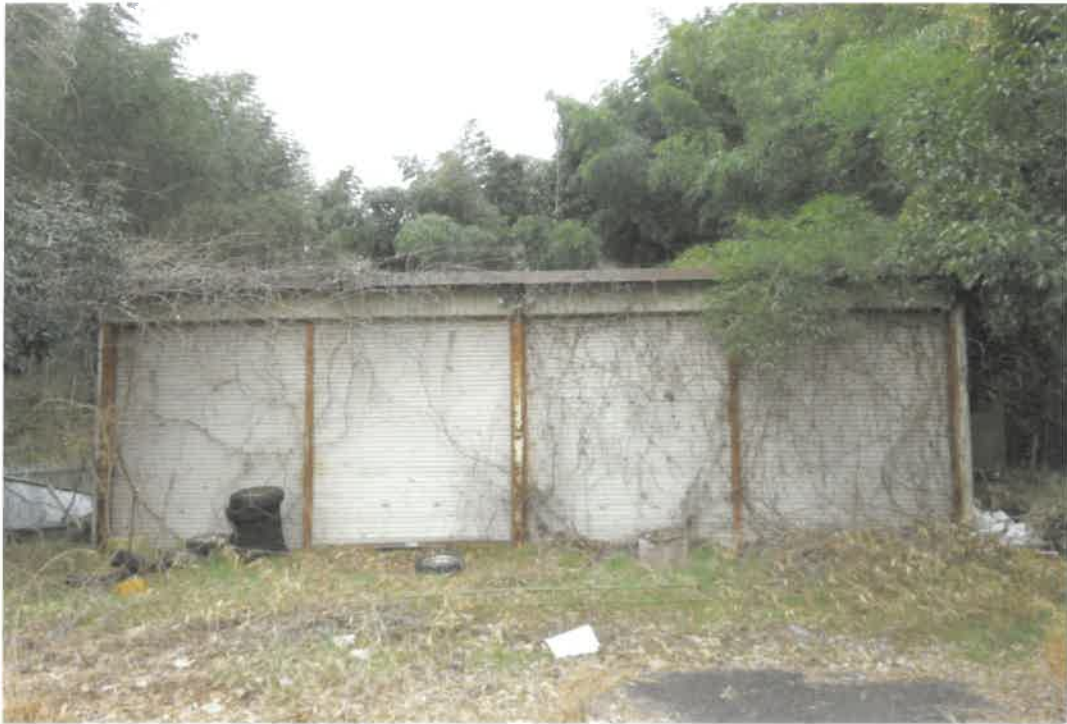
物件4建物の東方から撮影
