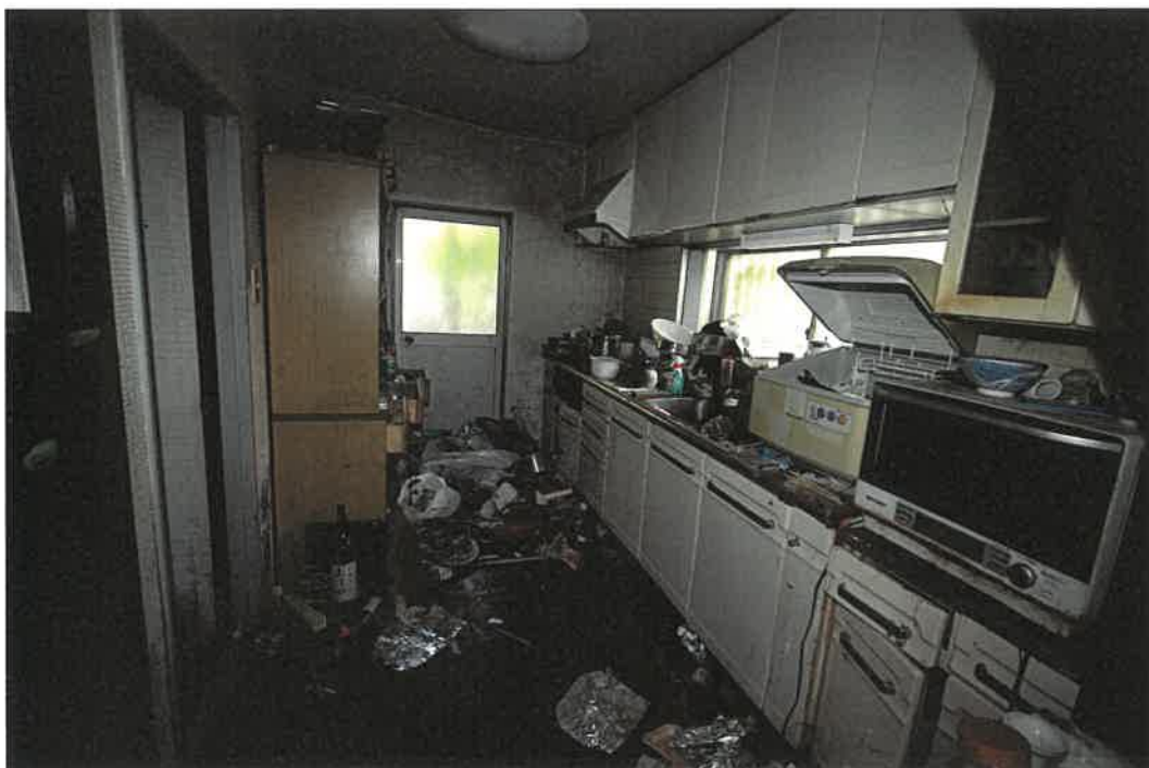
物件 3 建物 1 階室内
