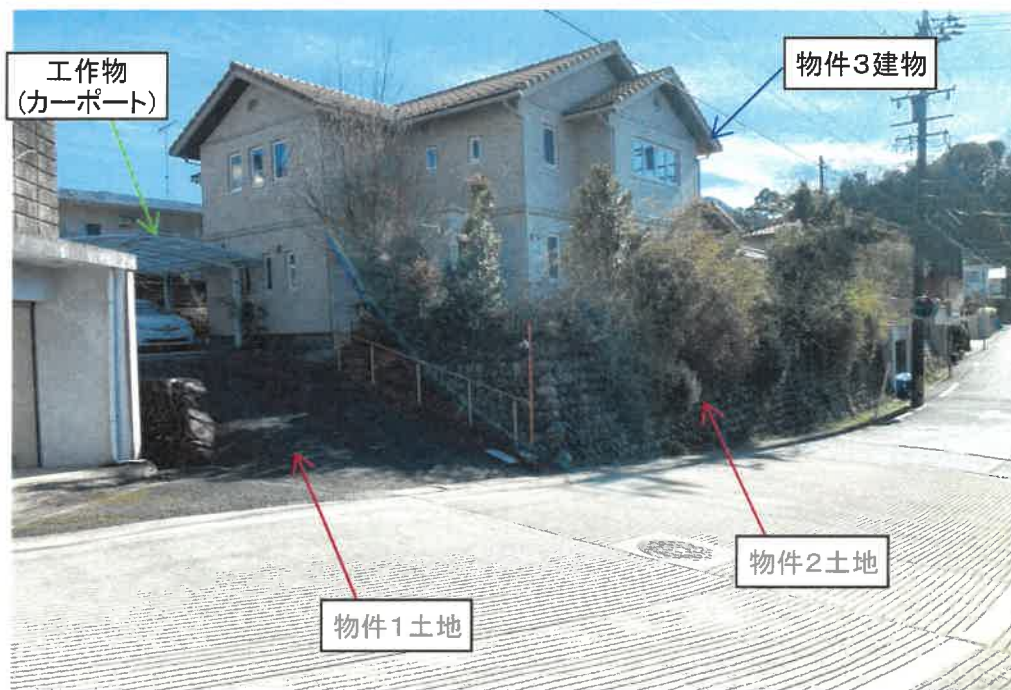
【 写真番号1 】 目的物件の北東方より撮影
