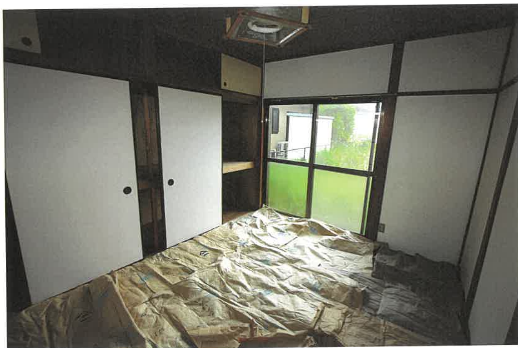
物件 2 建物 室内
