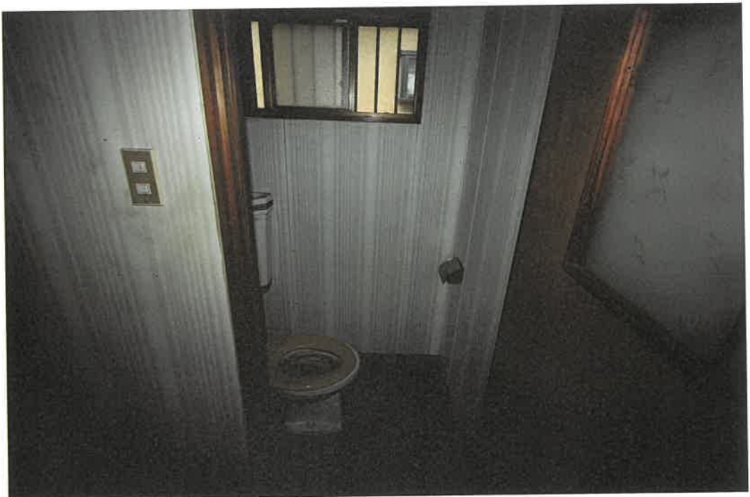
物件 2 建物 室内
