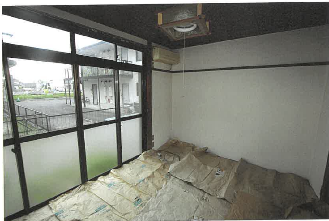
物件 2 建物 室内
