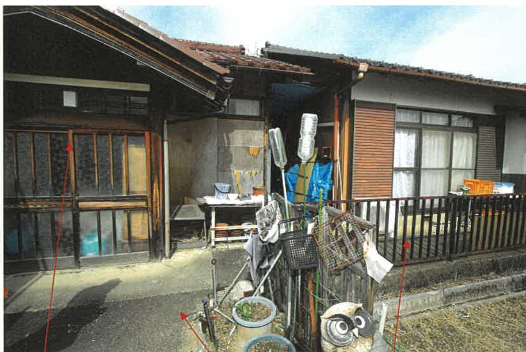
物件 1 附属建物
