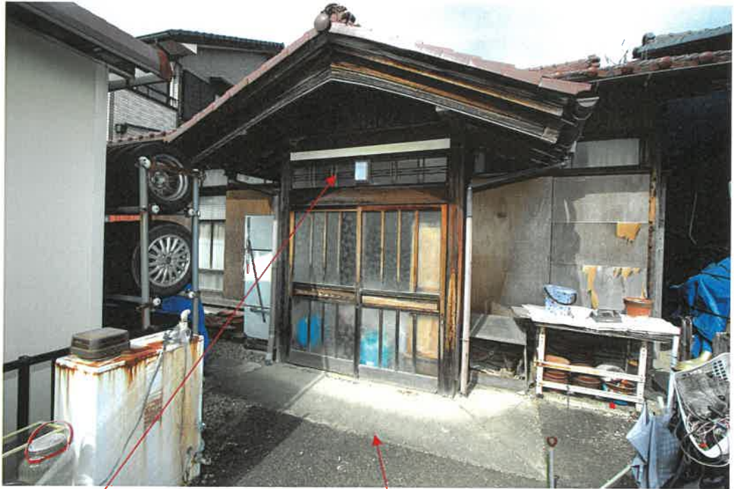
物件 1 附属建物
