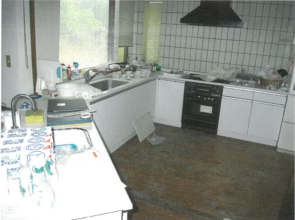
前同建物の1階室内
