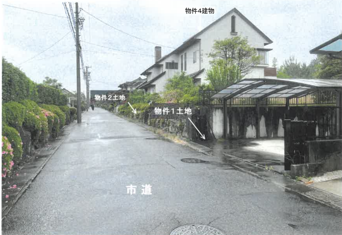
写真① 接道市道より撮影
