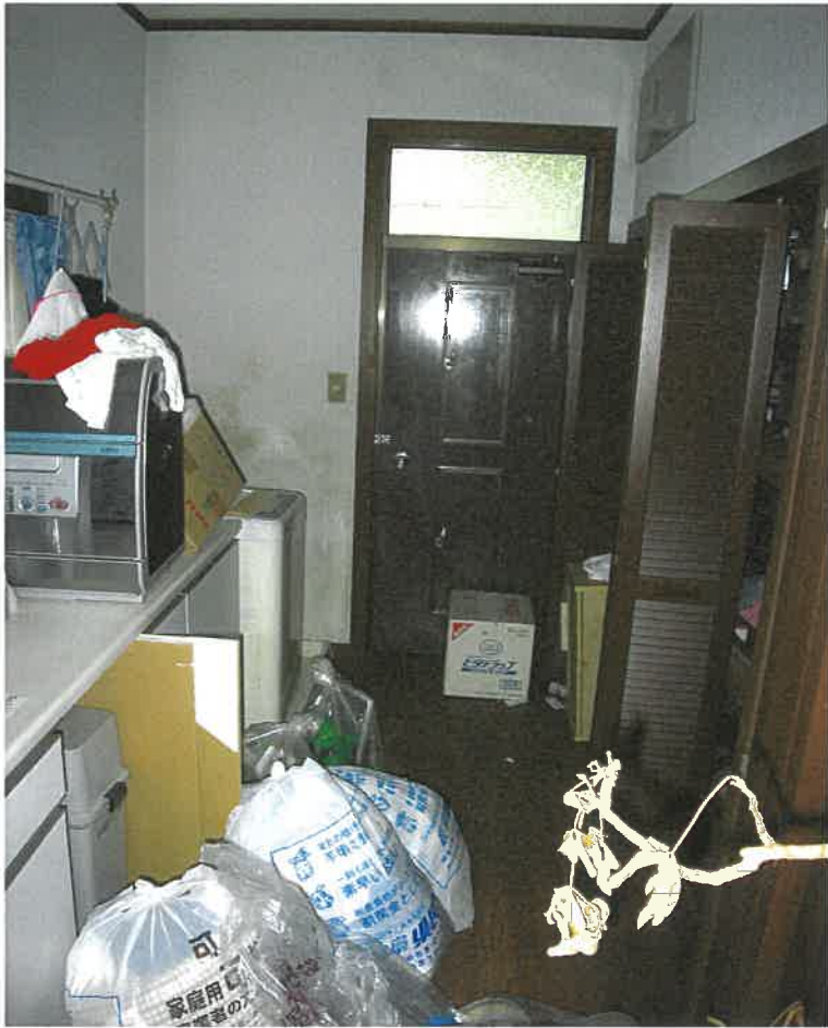
前同建物の1階室内
