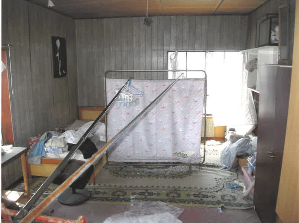
前同建物の3階室内
