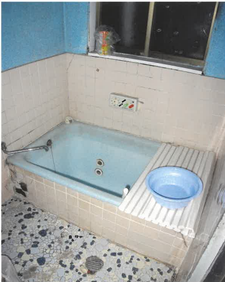
前同建物の1階室内
