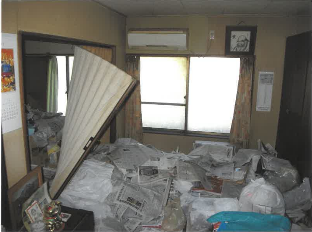
前同建物の2階室内
