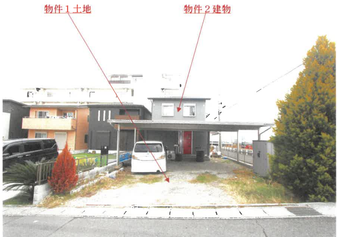
目的物件の現況写真
