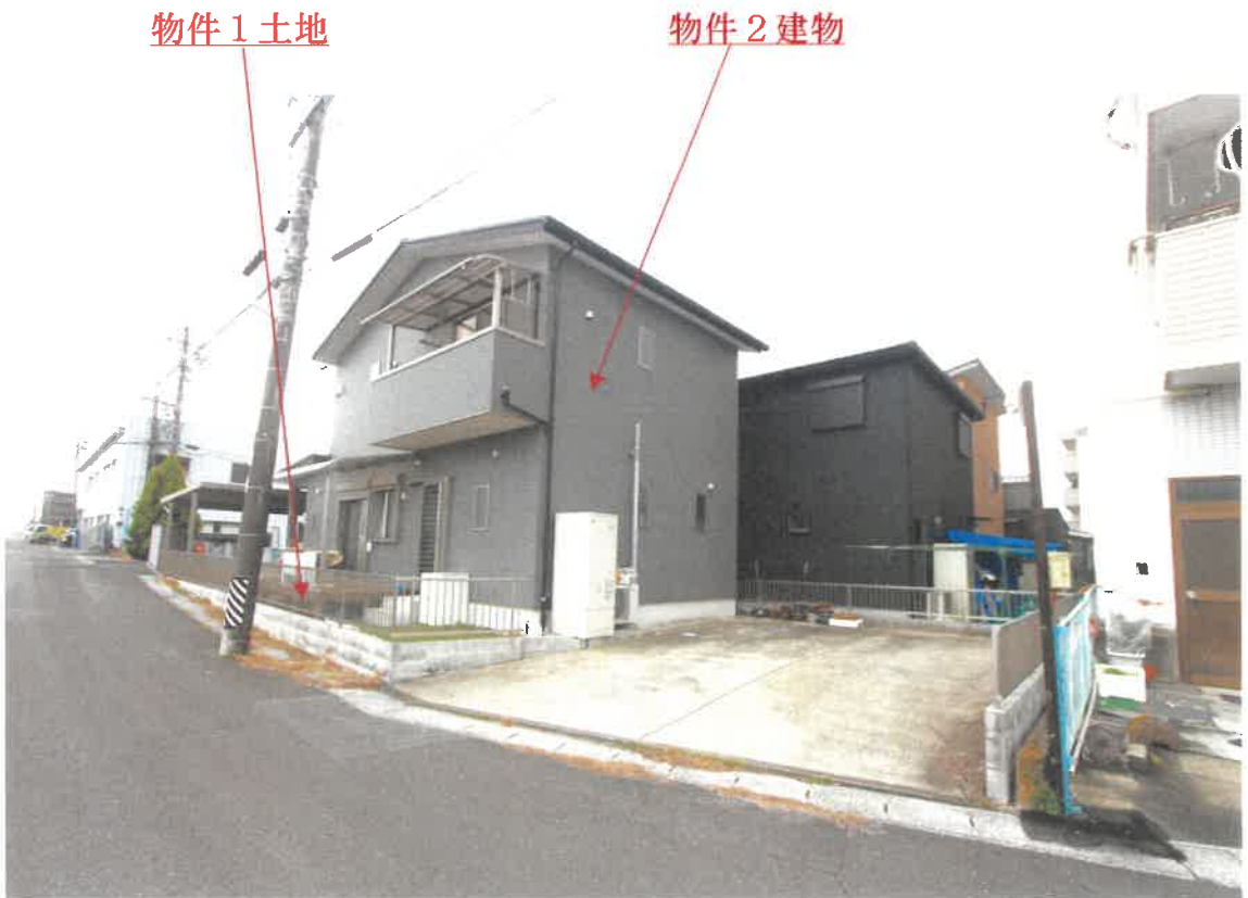
目的物件の現況写真
