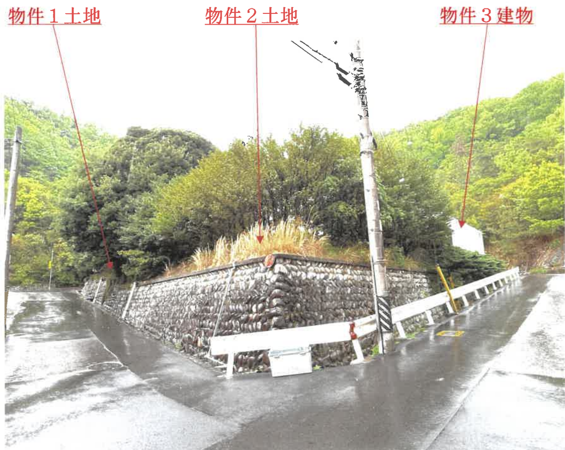
目的物件の現況写真
