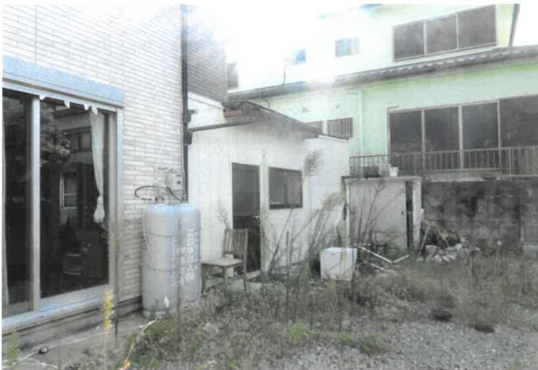
増築建物を北西方から撮影
