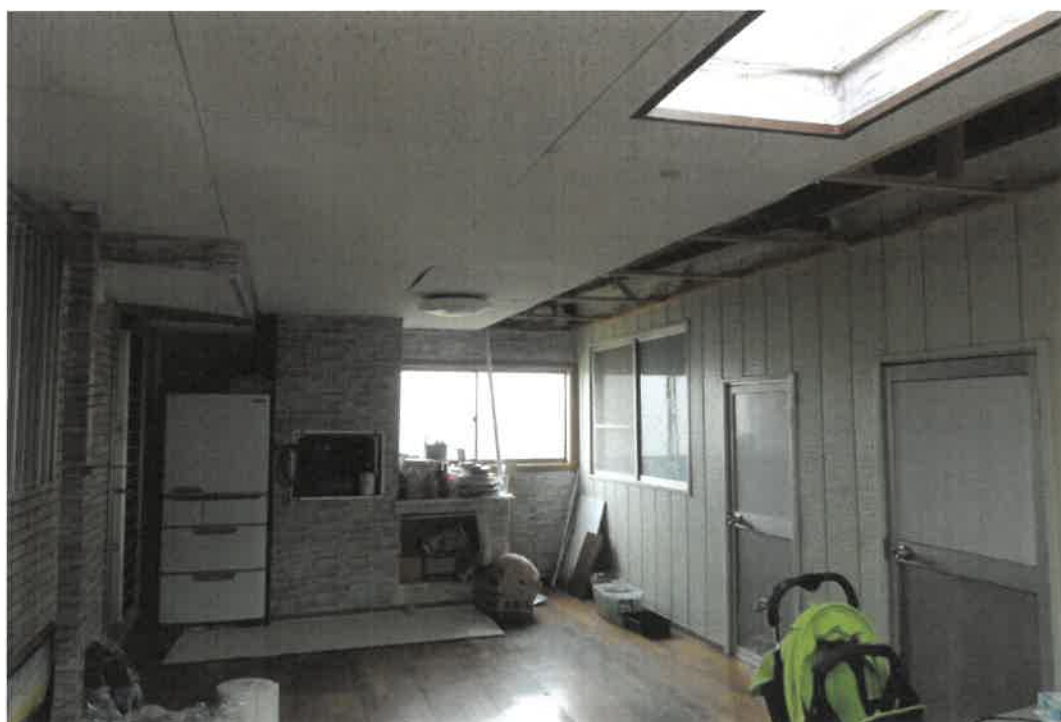
増築建物内部を東方から撮影
