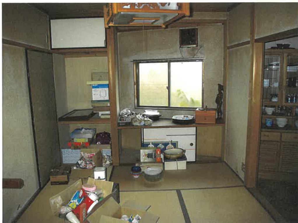
前同建物の2階室内
