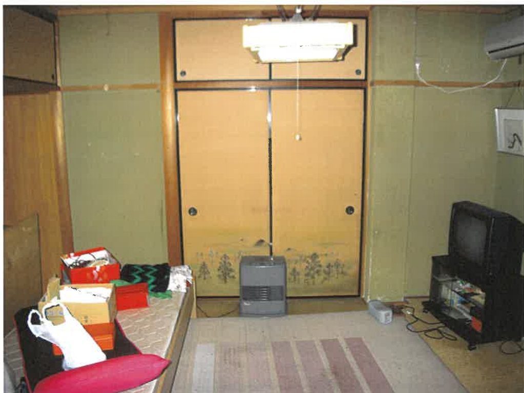
前同建物の2階室内
