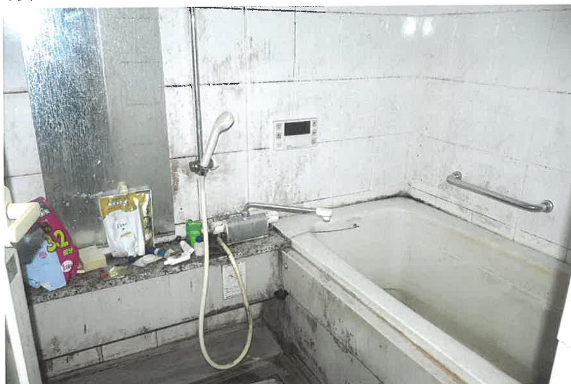
物件1 建物室内
