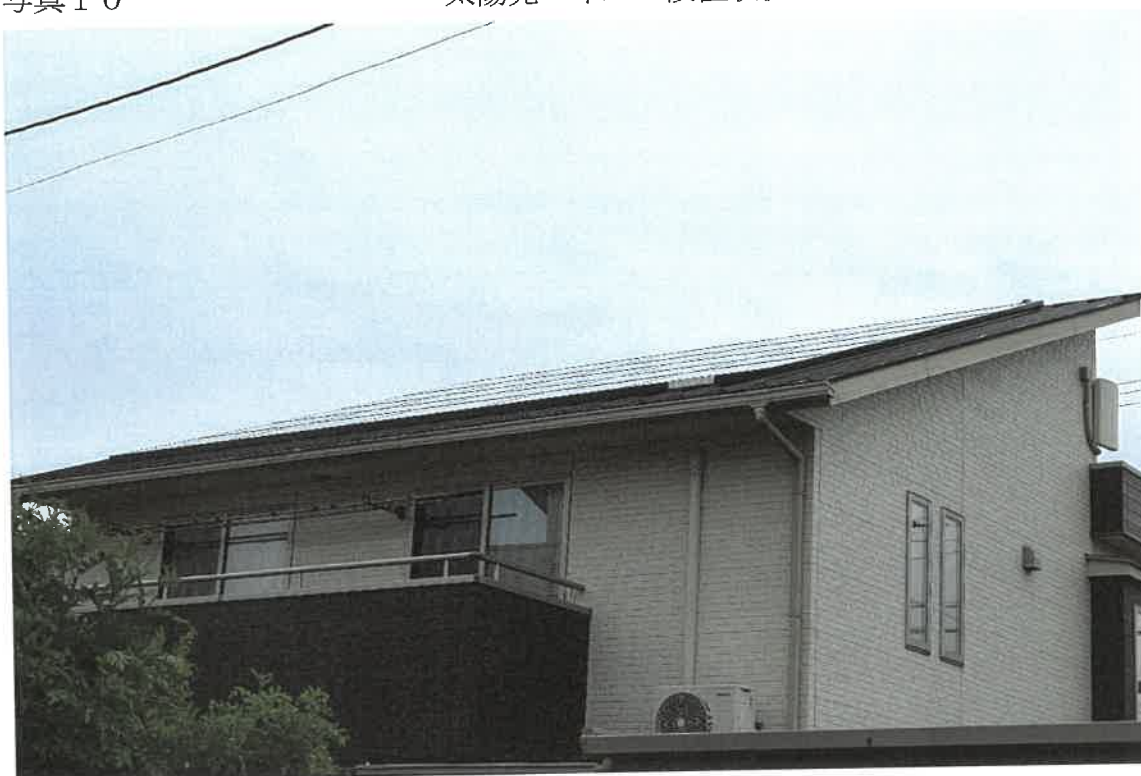
太陽光パネルの設置状況
