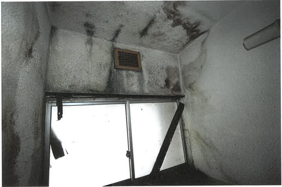
物件 2 建物室内
