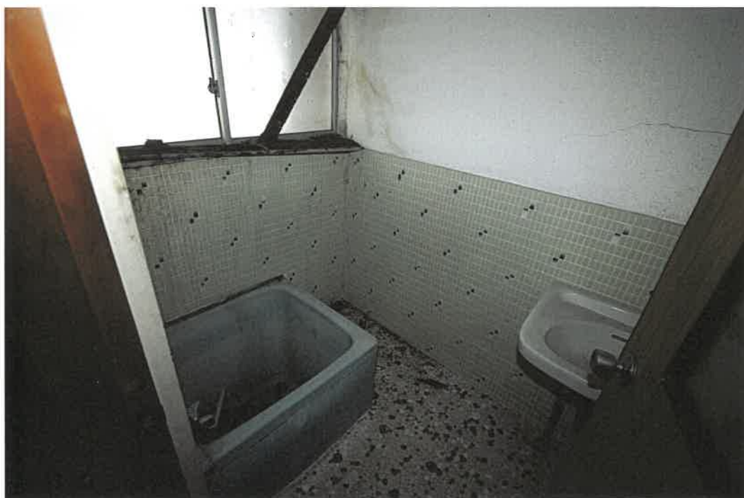
物件 2 建物室内
