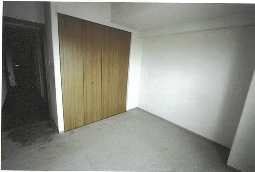
専有部分の建物 室内
