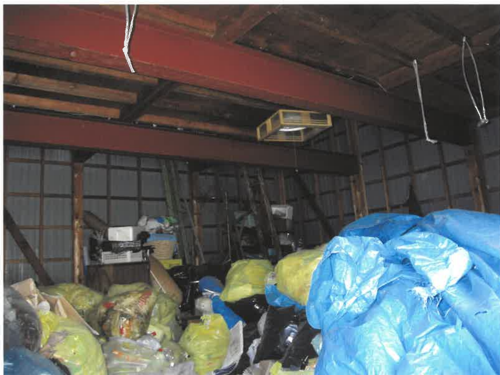
未登記附属建物1の車庫・物置内
