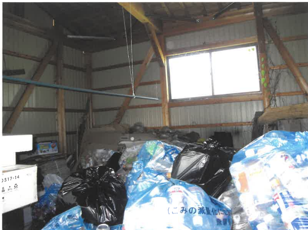
未登記附属建物2の車庫・物置内
