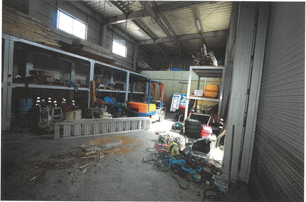
物件 2 建物室内
