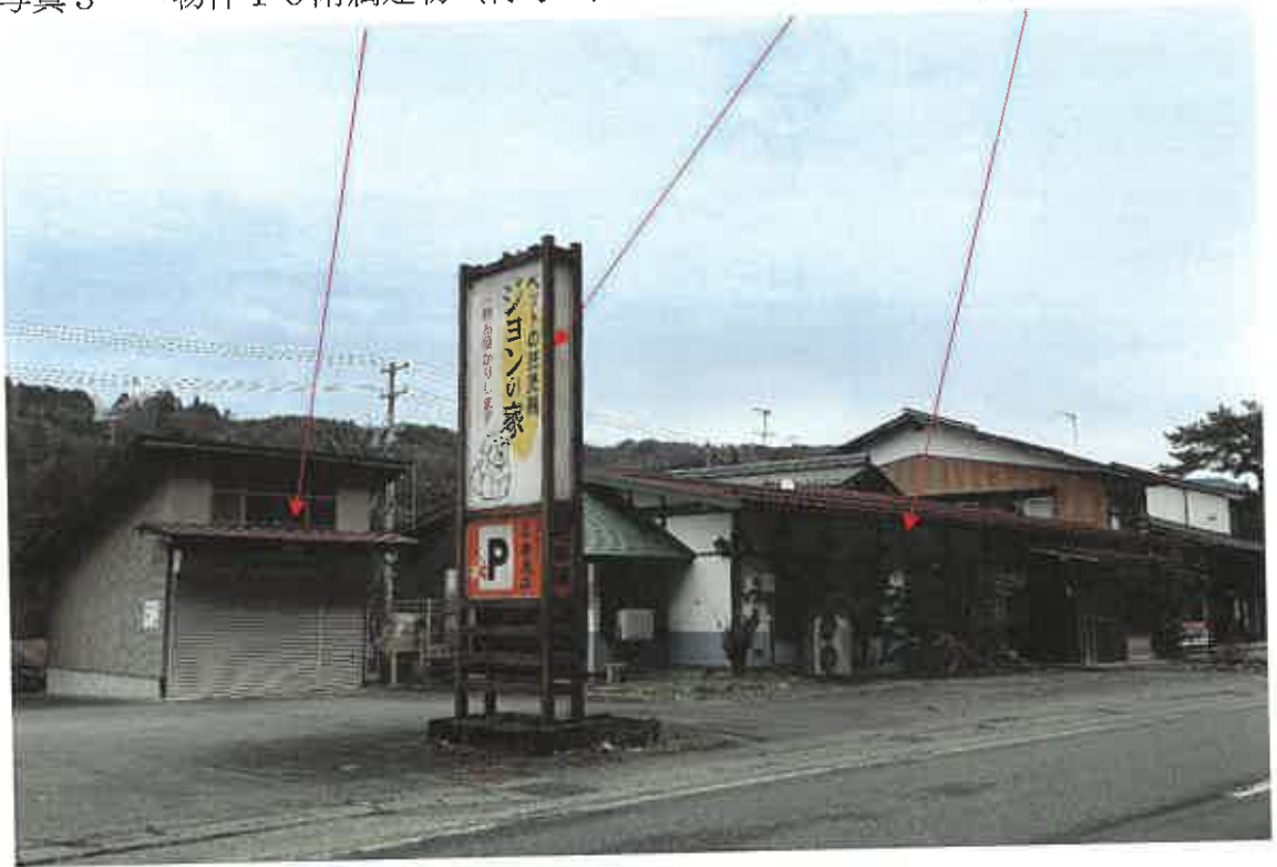
写真3 物件10附属建物（符号2） 看板（工作物） 物件8建物
