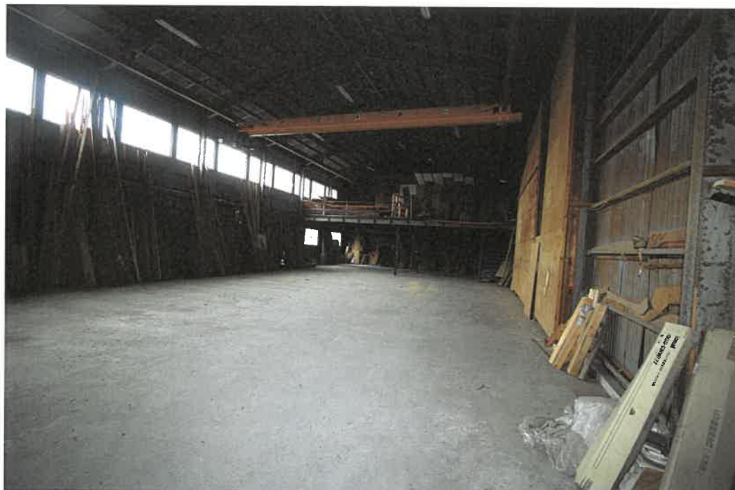
物件 4 主建物 室内
