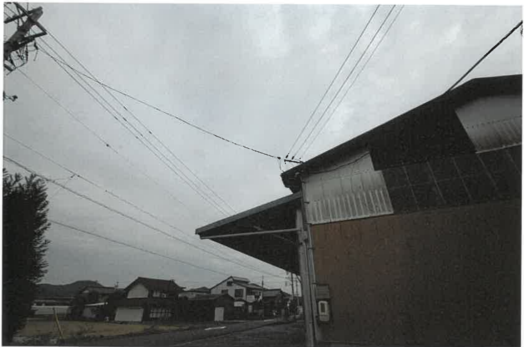
隣家から電線を配線を受けている
