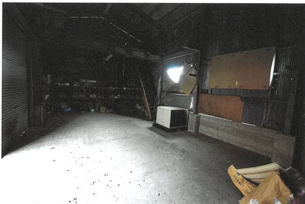
物件 4 附属建物 1 室内
