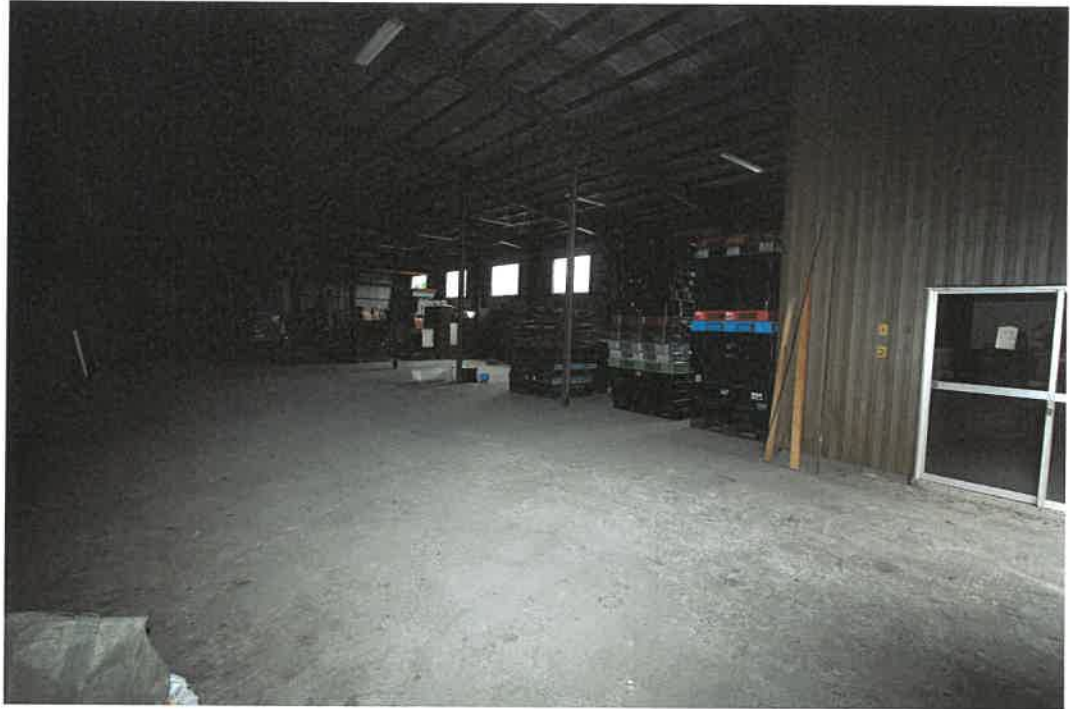
物件 4 主建物 室内
