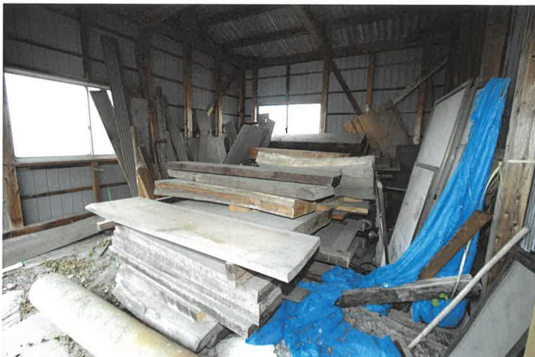
物件 4 附属建物 1 室内
