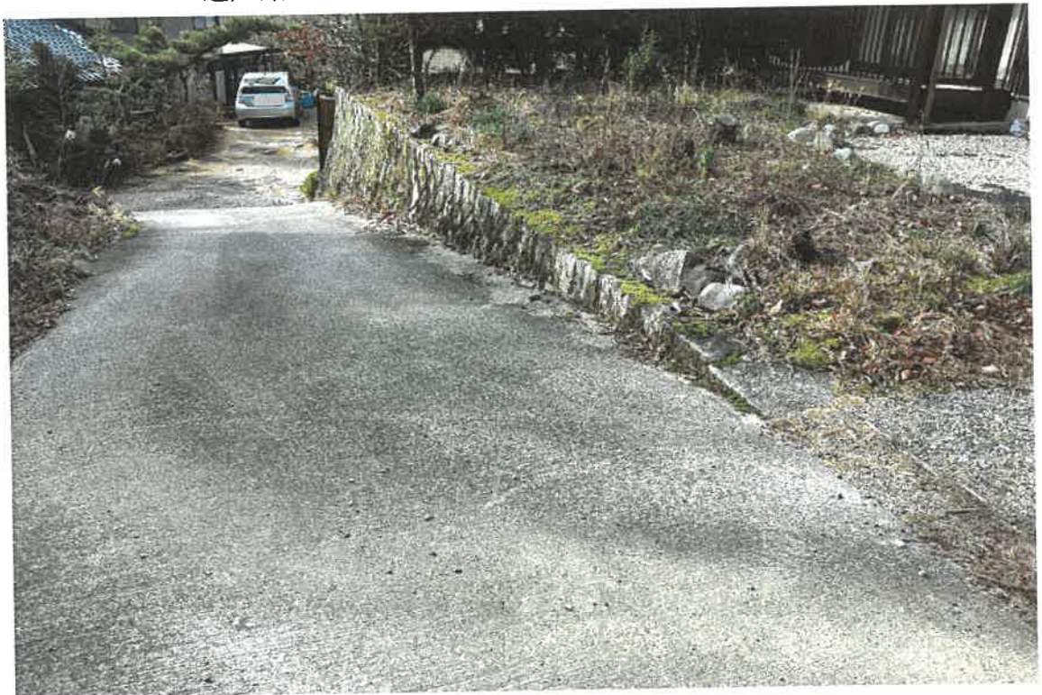
写真 1 4 物件 1 土地の南東側隣地（地番 1 1 4 7 番 3 0）の一部が同土地への進入路となっている状況
