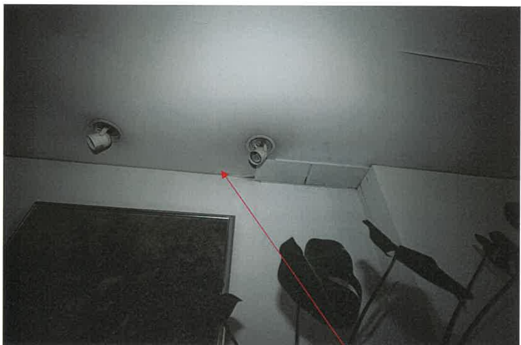
物件 4 建物 1 階室内
