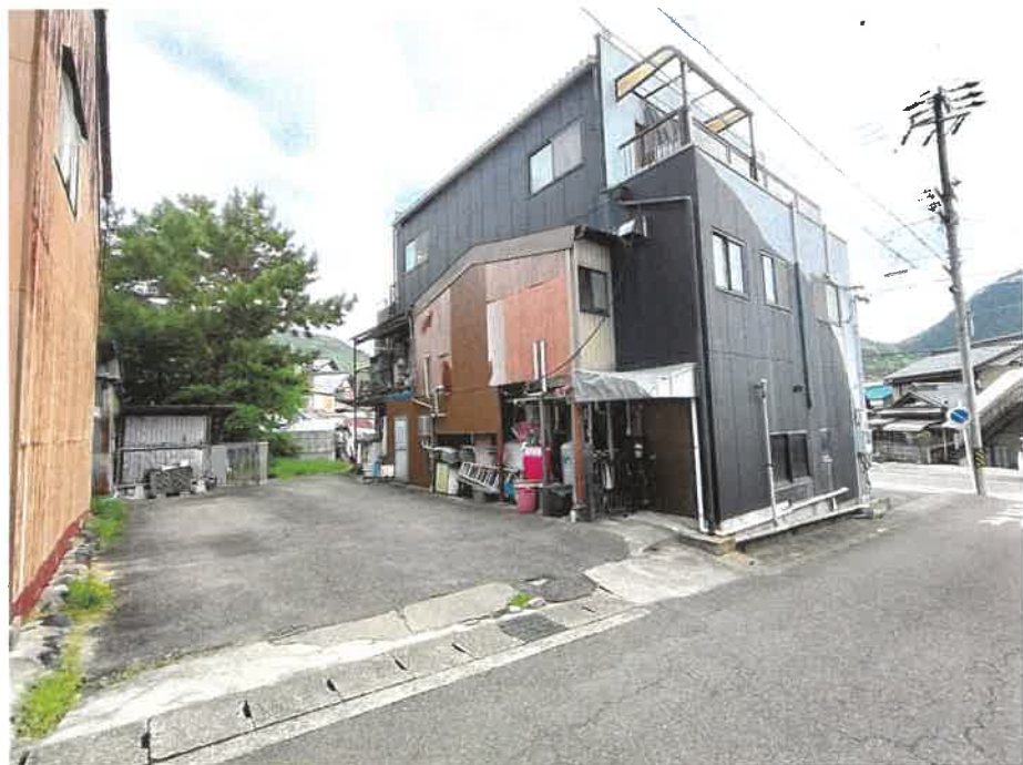
写真番号2 目的物件の西方より撮影
