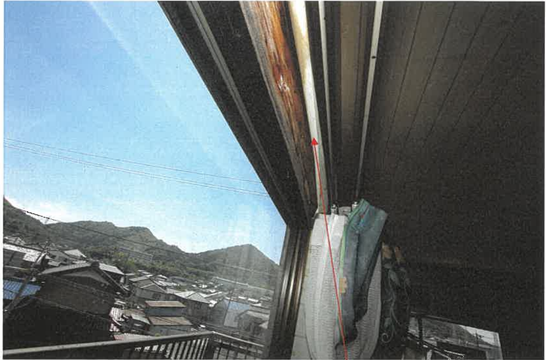
物件 4 建物 3 階室内
