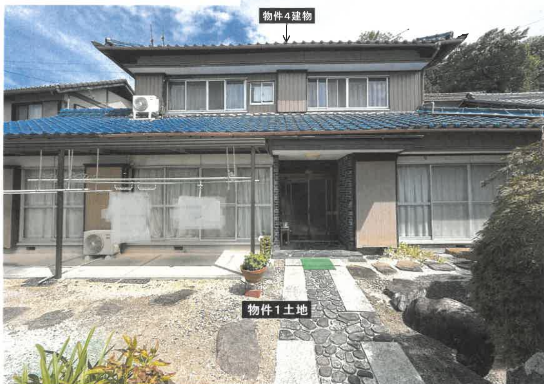
写真③ 物件4建物入口正面を撮影
