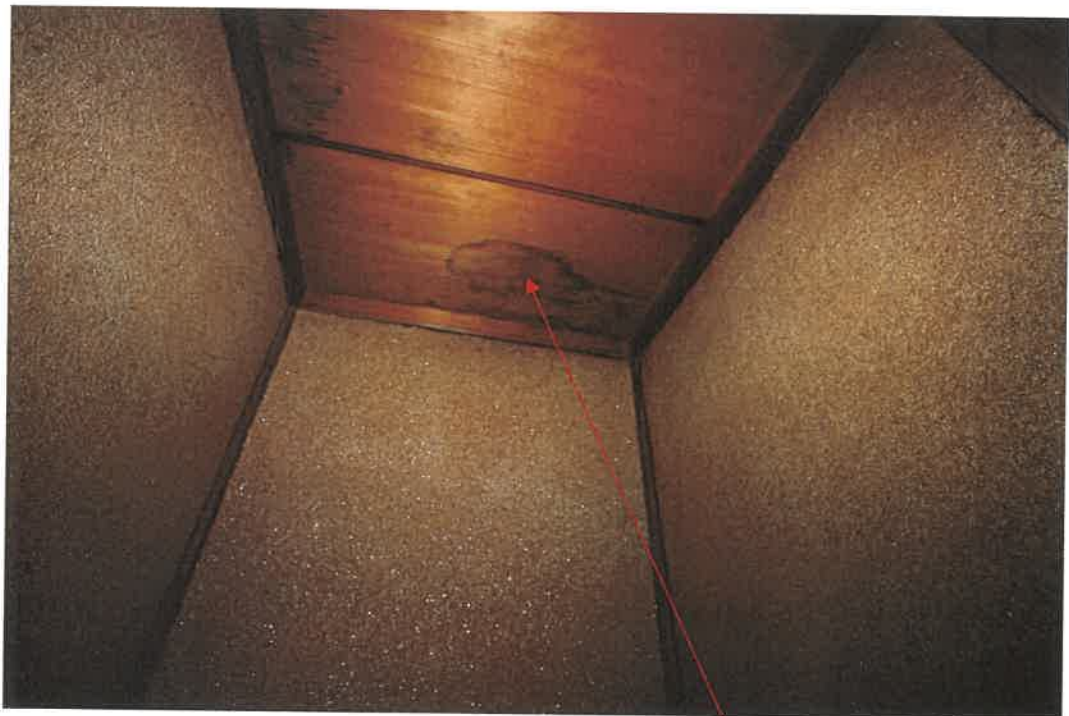
物件 4 建物 2 階室内
