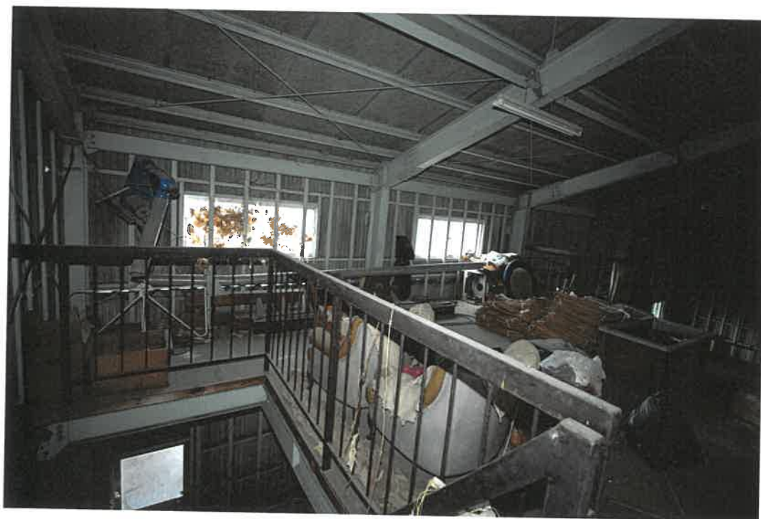
物件 7 建物 2 階室内
