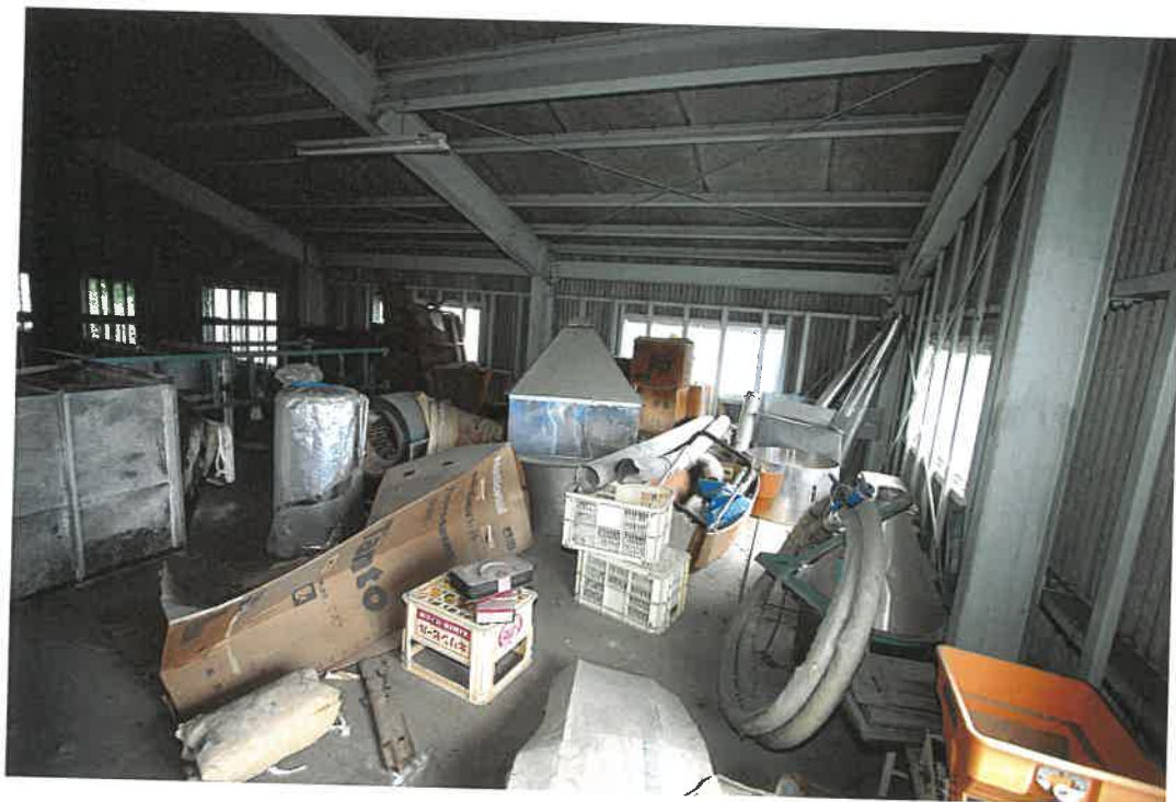
物件 7 建物 2 階室内
