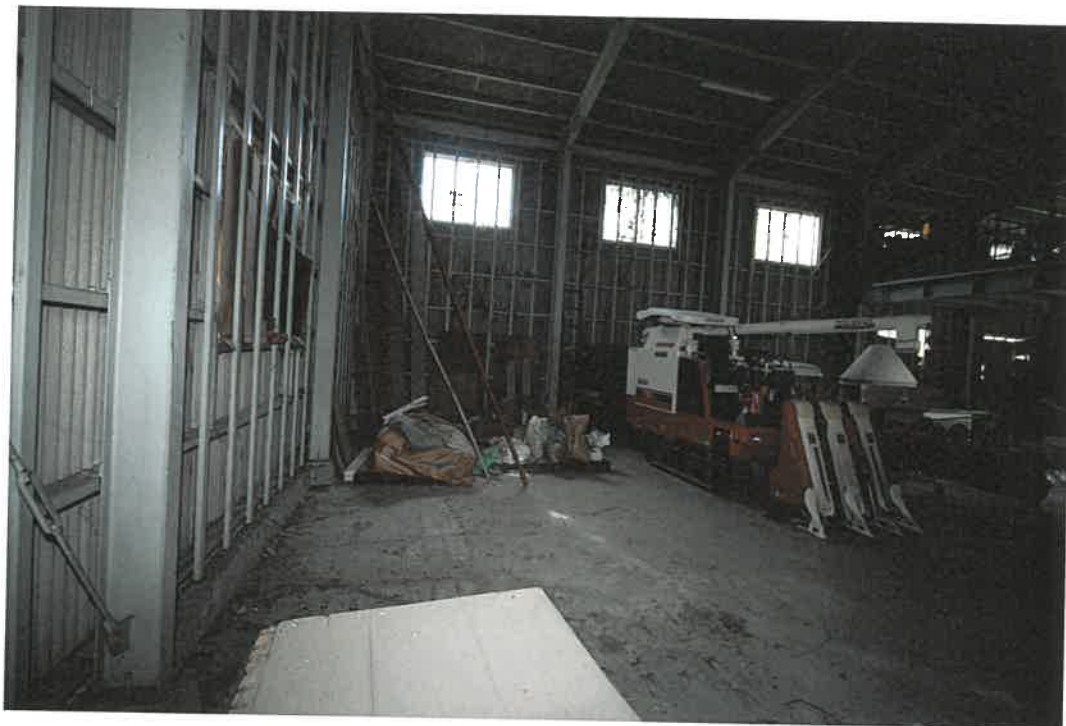
物件 7 建物 1 階室内
