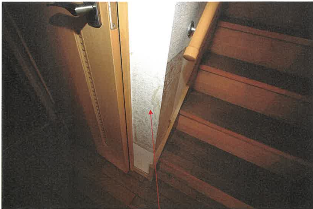
物件 2 建物 1 階室内
