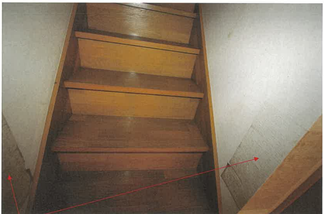
クロスの剥がれを補修した痕
