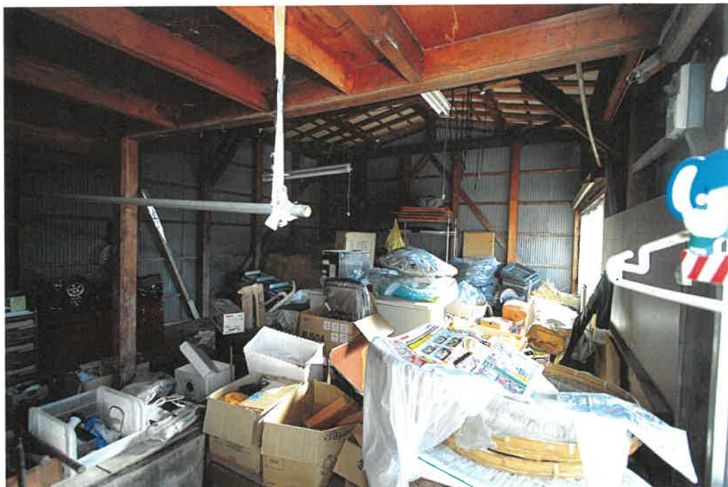
物件 3 建物 1 階室内
