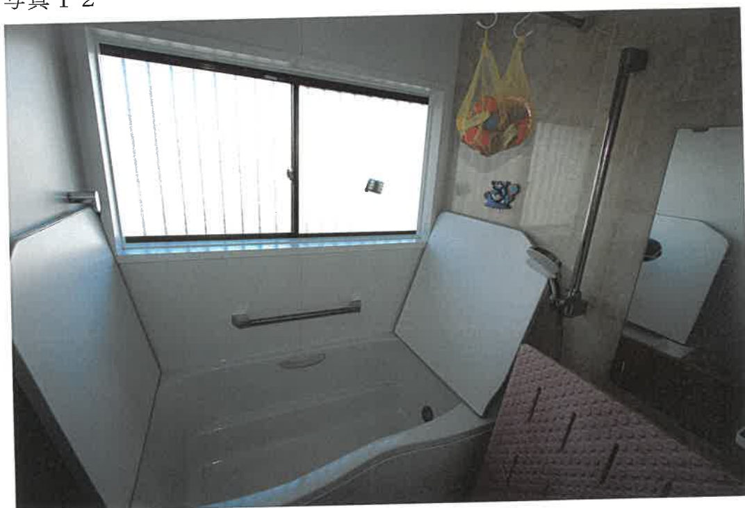
物件 3 建物 1 階室内
