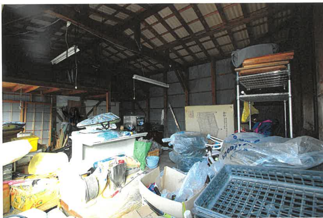
物件 3 建物 1 階室内
